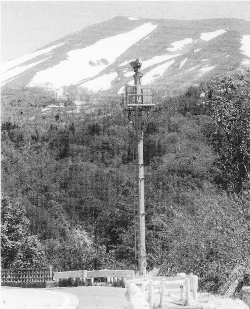
図4 ITVカメラ装置 道路側帯の高さ10mのポール上に設置されている。
