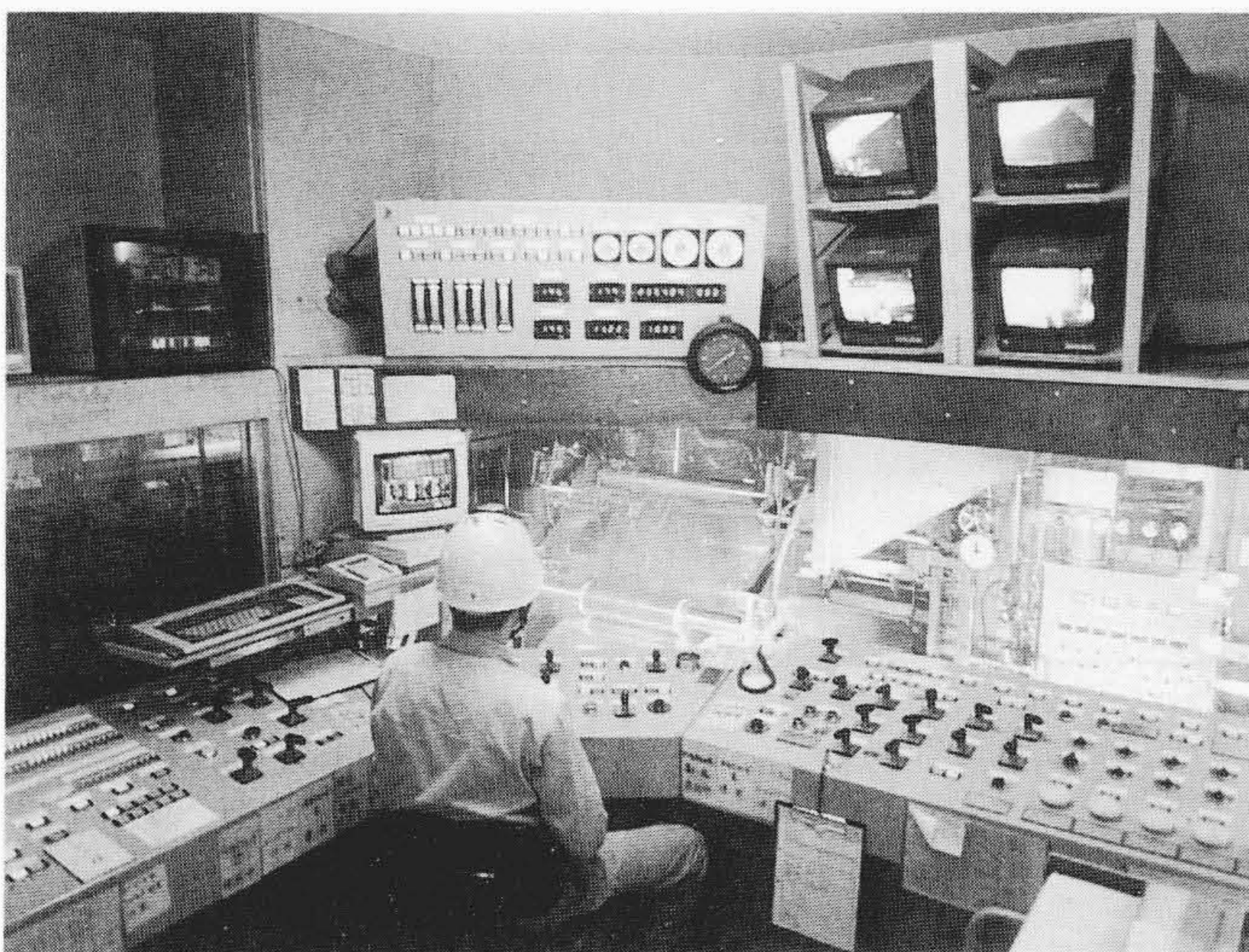
図5 2FCMの運転室 運転室には、オペレータが自動制御を入・切したり手介操作を行うための操作デスク、セットアップデータや板形状を操作するためのCRTなどが設置されている。
