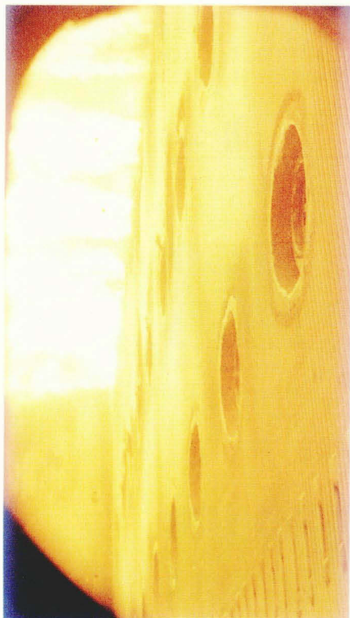
図13 1,000 MWボイラでの保証最低負荷運転時の火炎状態 オーストラリア炭(燃料比2.2)を保証最低負荷で専焼(油助燃なし)を実施した場合のボイラ火炉内の燃焼状況を示す。鮮明な輪郭を持つ輝度の高い火炎を形成している。
