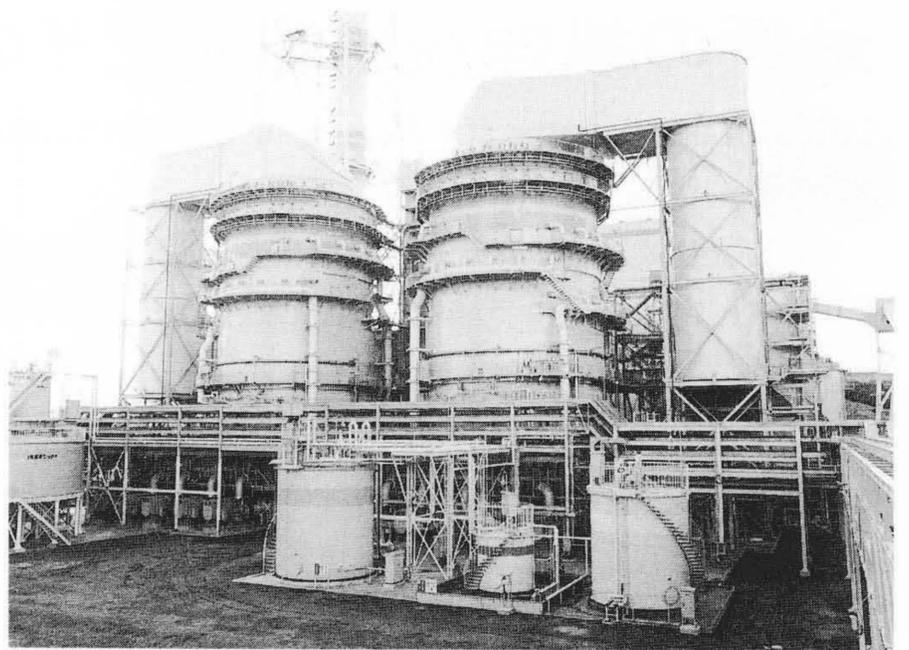
図2 脱硫装置外観 電発・松浦火力発電所1号機用排煙脱硫装置の吸収塔周りの外観を示す。吸収塔は500 MWを一列で処理できる容量である。
