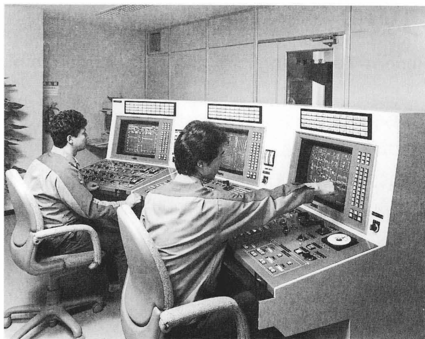
図2 東京電力株式会社 福島第一原子力発電所向け小型シミュレータ CRT 3台は、プラント状態の監視と操作スイッチ(タッチスクリーン)用として使われる。
