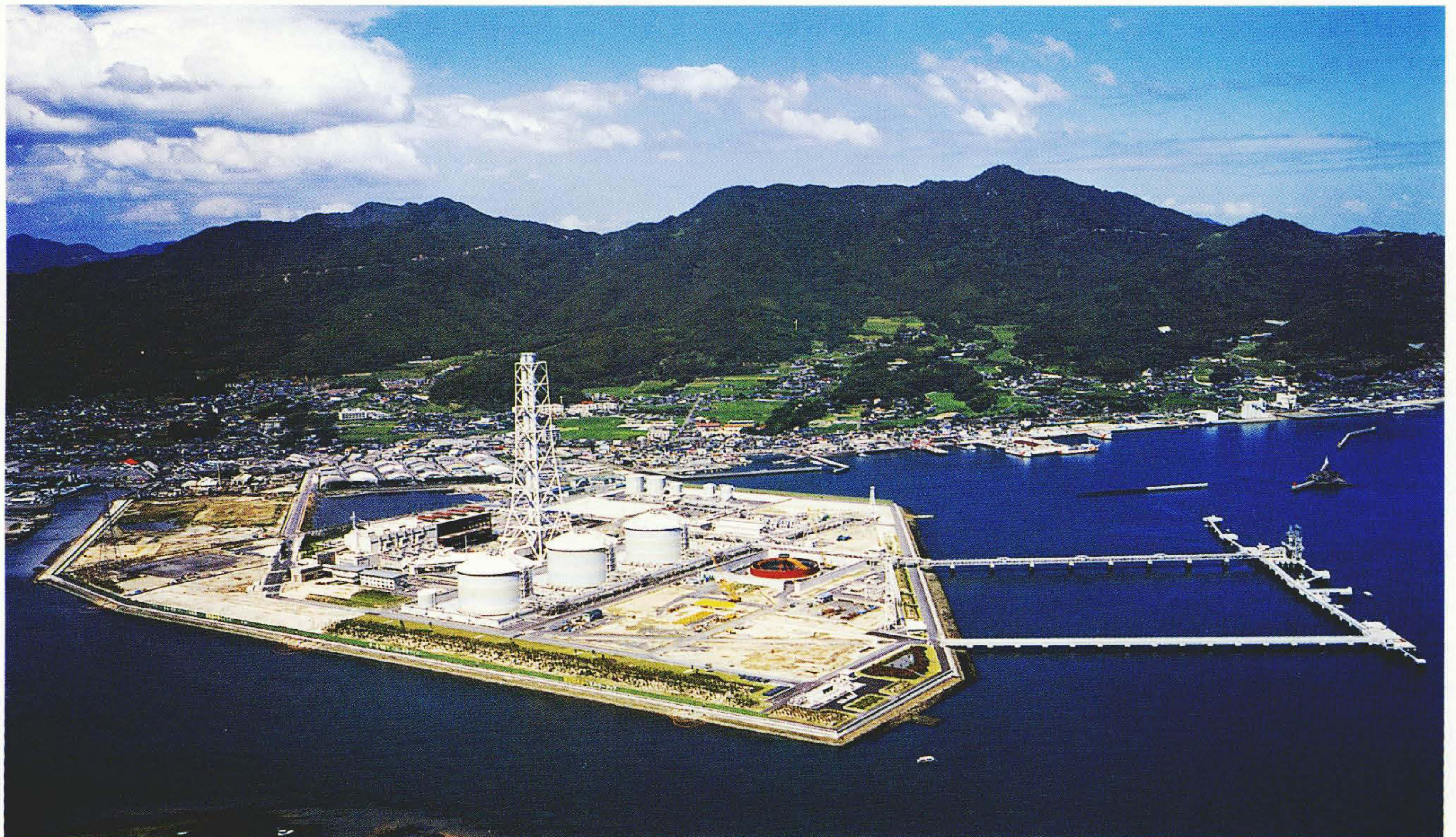
営業運転に入った柳井発電所 1-1 系列(350 MW)の全景
