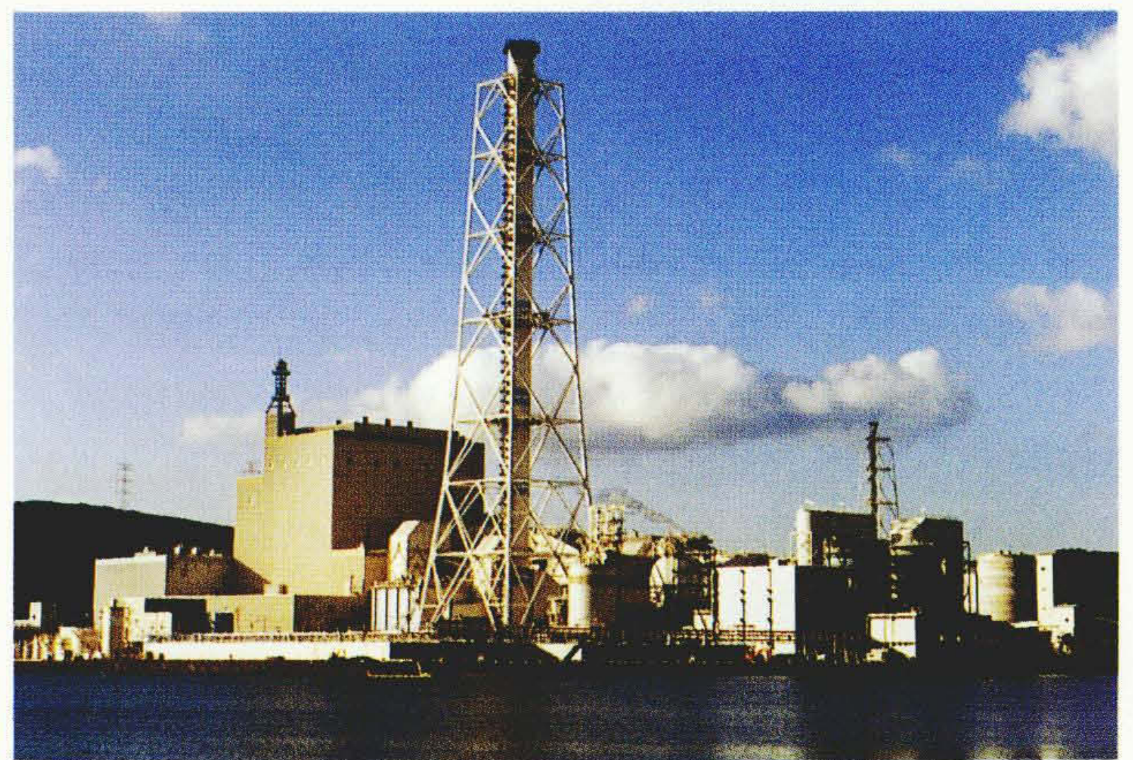
電源開発株式会社松浦火力発電所全景
