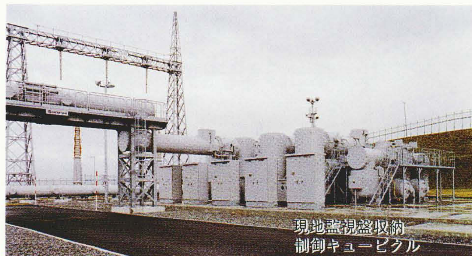
300 kV全三相一括形ガス絶縁開閉装置
