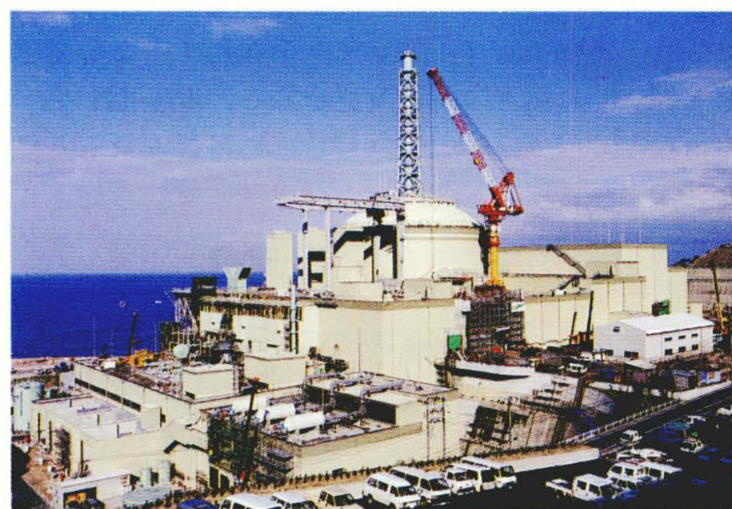
もんじゅ建設状況
