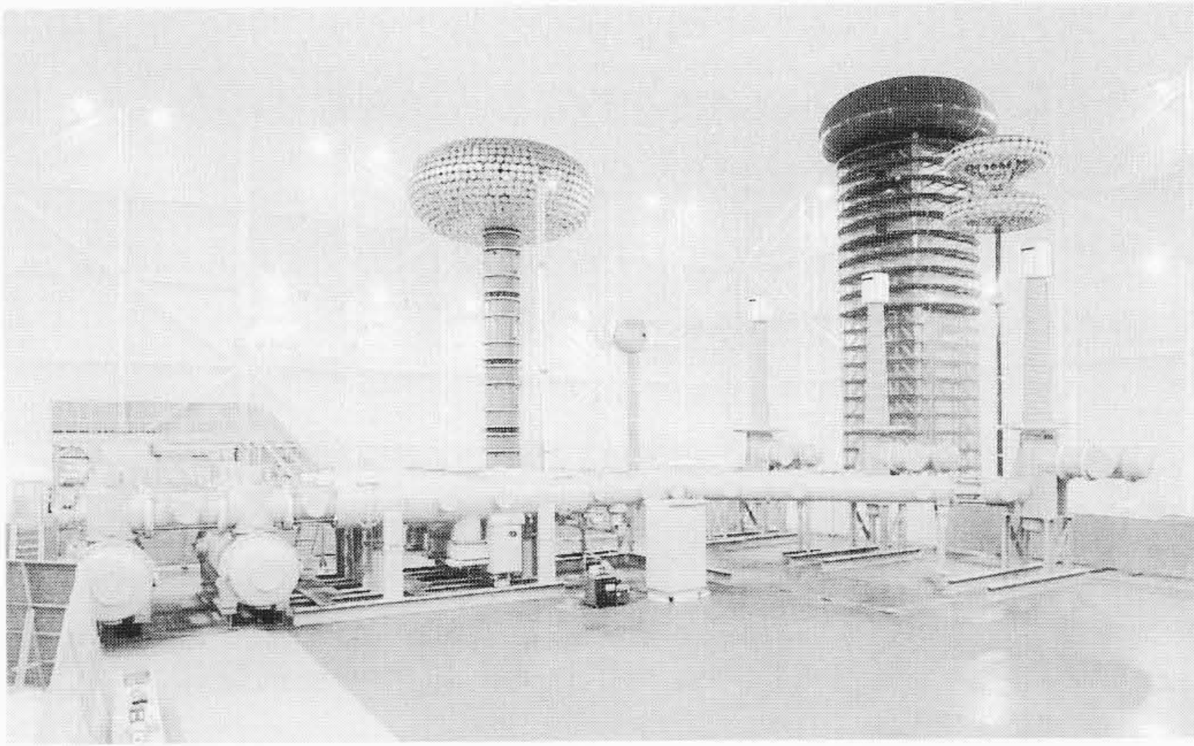
図6 東京電力株式会社 新山梨変電所用550 kV絶縁合理化形ガス絶縁開閉装置 三相一括化、複合化により小形・軽量化を図っている。
