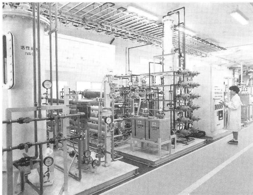
図2 超純水製造装置 TOC, DO, 微粒子除去に新しい技術や装置を使用し, 超純水を高度に処理している。
