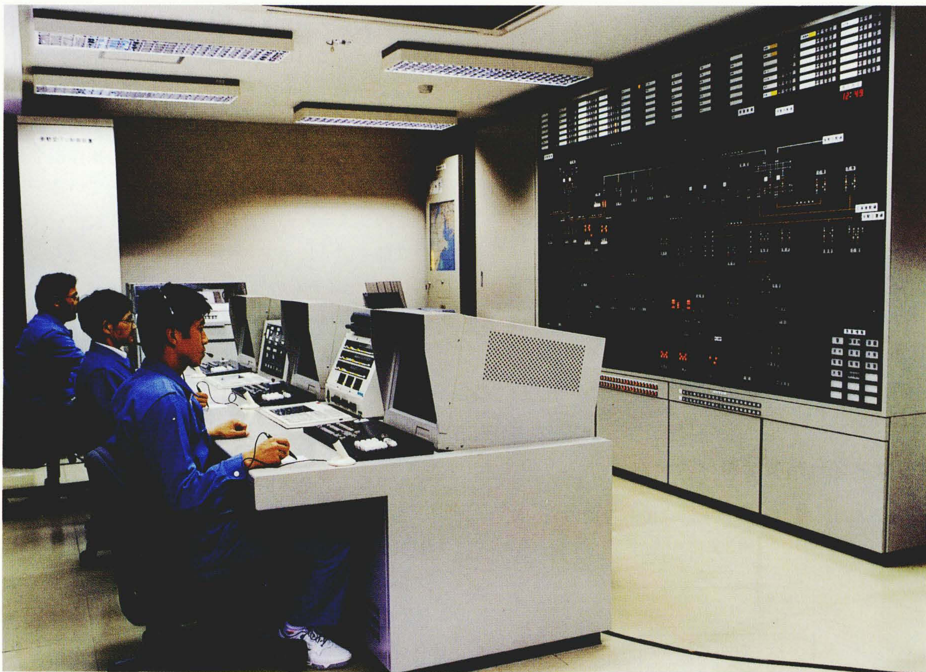
操作室外観 中部電力株式会社松阪電力センターに設置された電力センター指令情報システムを示す。
