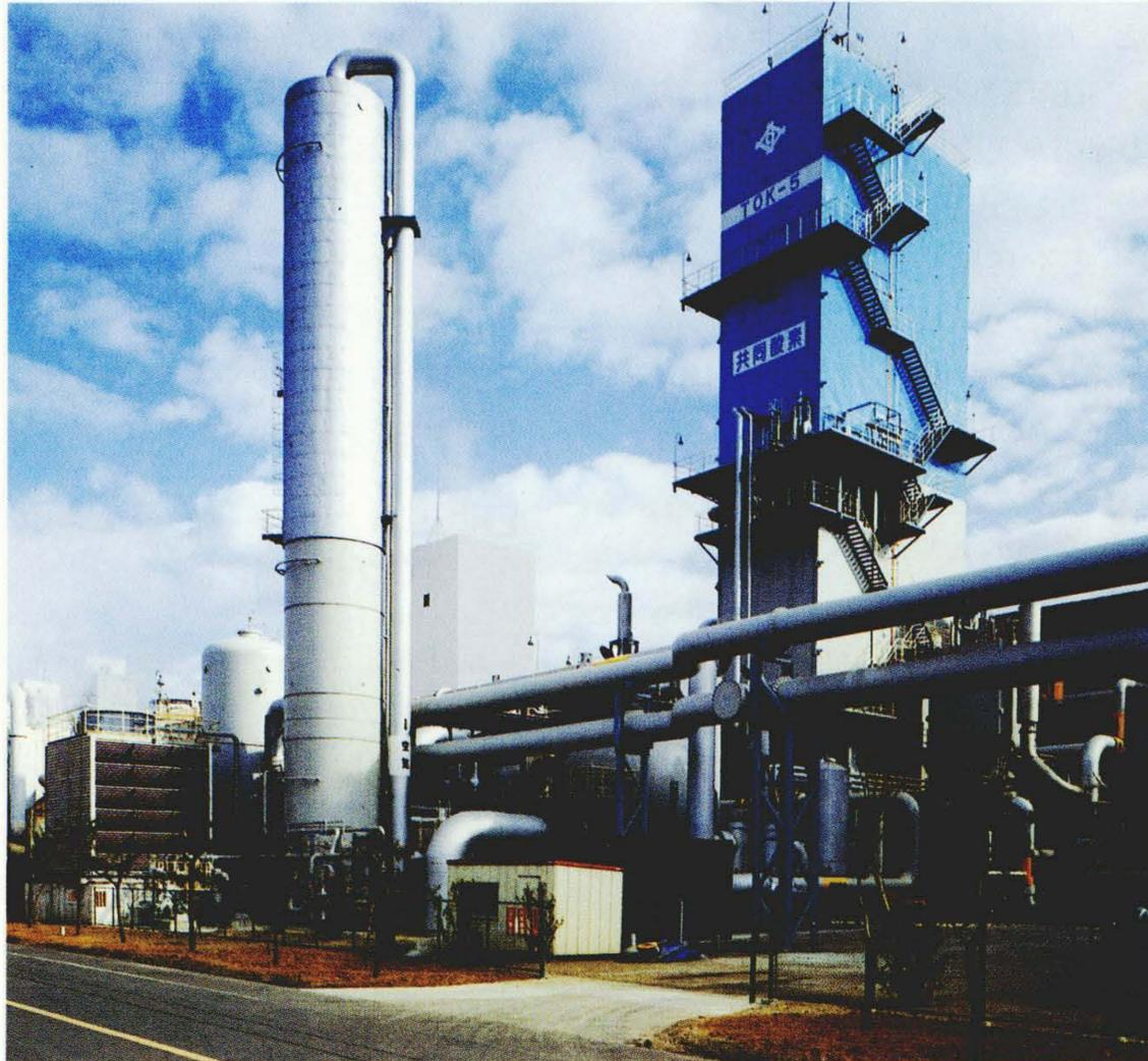
共同酸素株式会社 鹿島工場納め30000TOプラント® パッケージ化を図り、省エネルギー、エキスパート制御方式を採用した共同酸素株式会社 鹿島工場納めの酸素発生量30,000 m<sup>3</sup>N/hのTOプラント (Tonnage Oxygen Plant : 空気分離装置) (平成3年10月稼動)の外観を示す。
