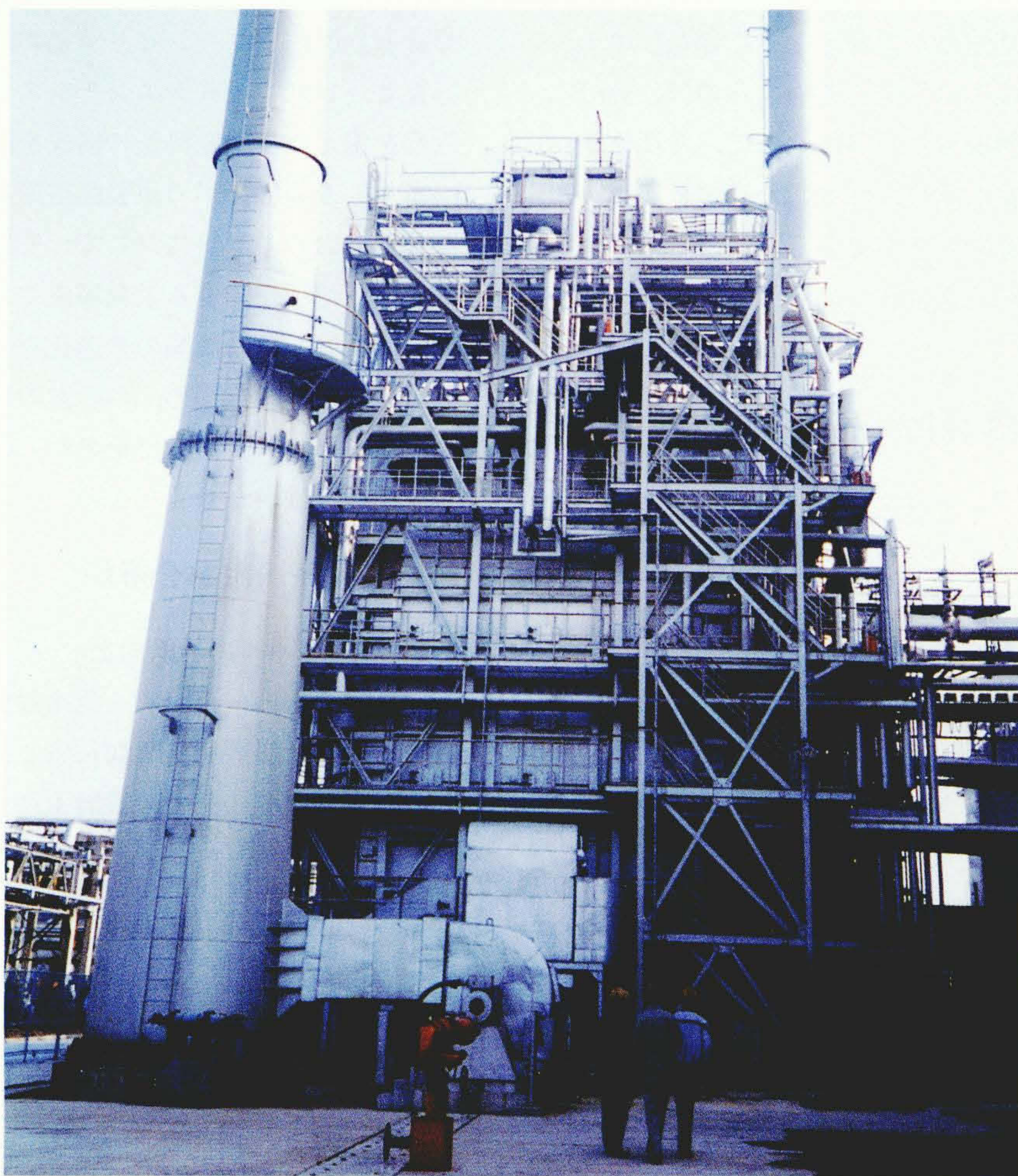
高効率多種原料熱分解設備 中華人民共和国納め(上海石化総廠)30,000 t/年ナフサおよび軽油熱分解設備の全容を示す。
