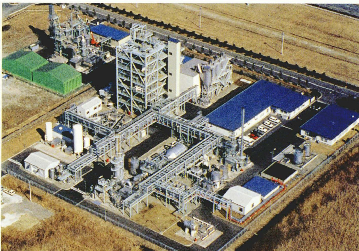
NEDO(新エネルギー・産業技術総合開発機構)・HYCOL(石炭利用水素製造技術研究組合)納めパイロットプラントの全景 千葉県袖ヶ浦市の敷地約1万5,000 m<sup>2</sup>に設置したガス化圧力3 MPa, 石炭処理量50 t/dパイロットプラントの全景を示す。
