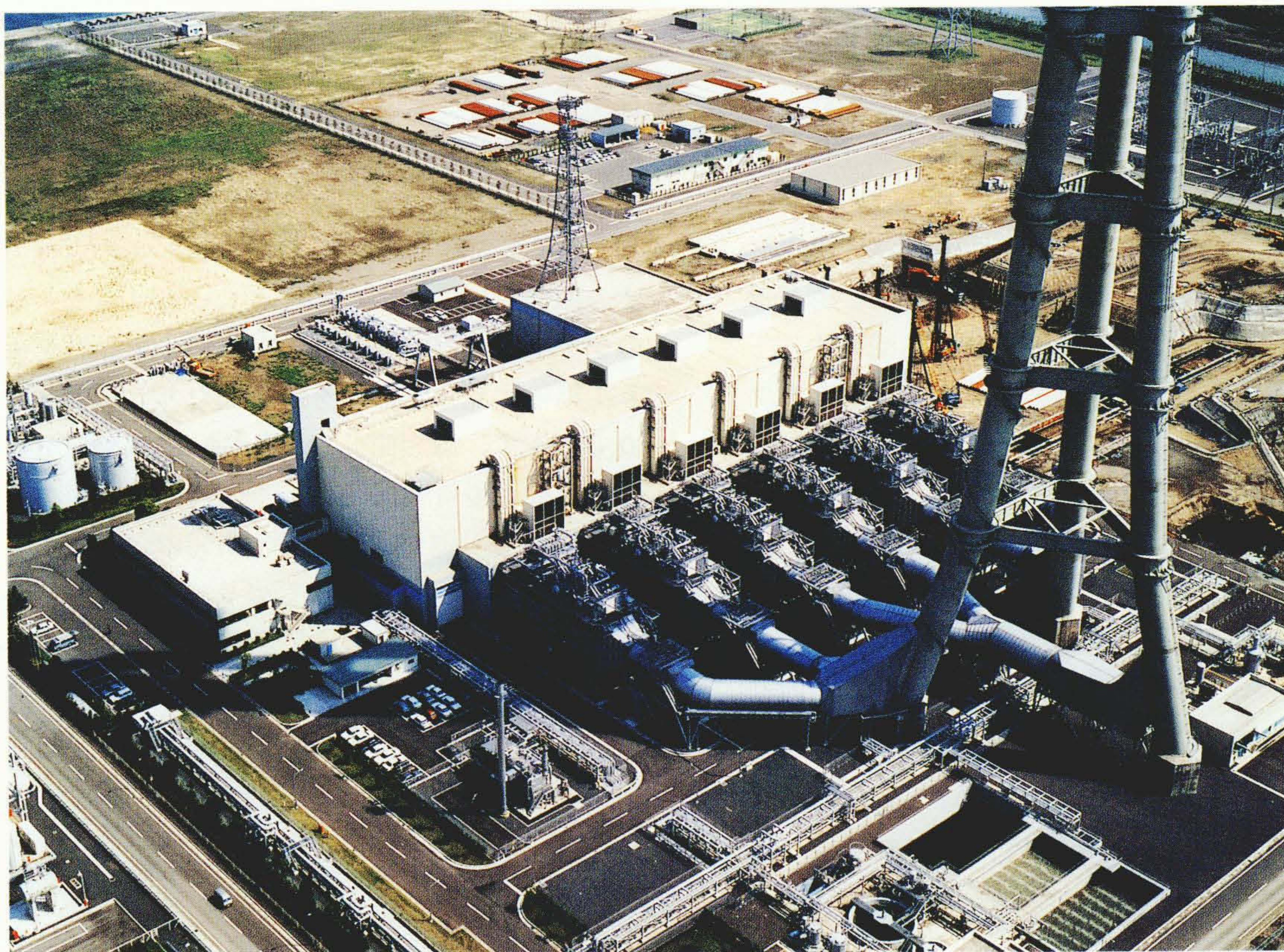
九州電力株式会社新大分発電所納めコンバインドサイクル発電プラント I号系列690 MWコンバインドサイクル発電プラントの全景を示す。
