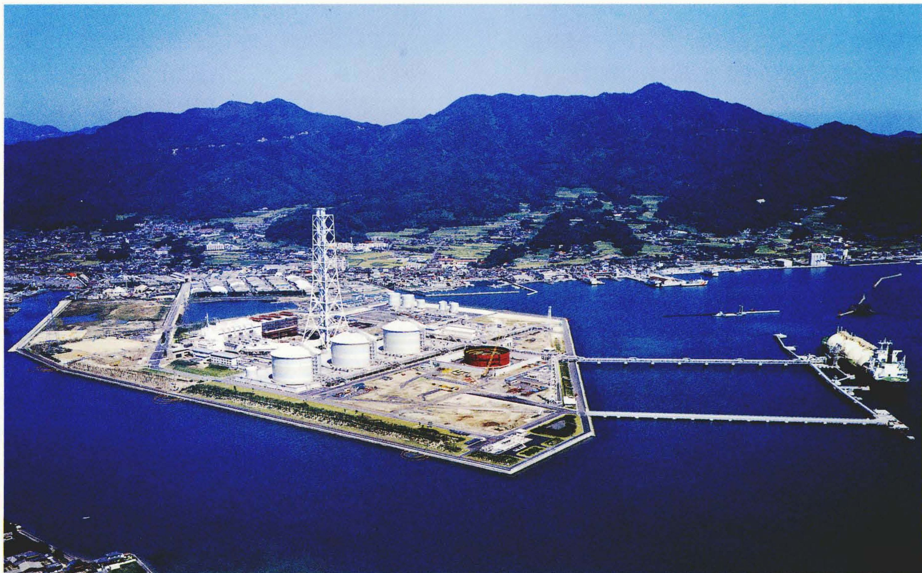
中国電力株式会社柳井発電所の全容 1, 2号系列のおの700 MWの本格的なコンバインドサイクル発電プラントである。平成2年11月に1-(1)号系列が営業運転開始となり、現在2号系列の建設を急ピッチで進めている。
