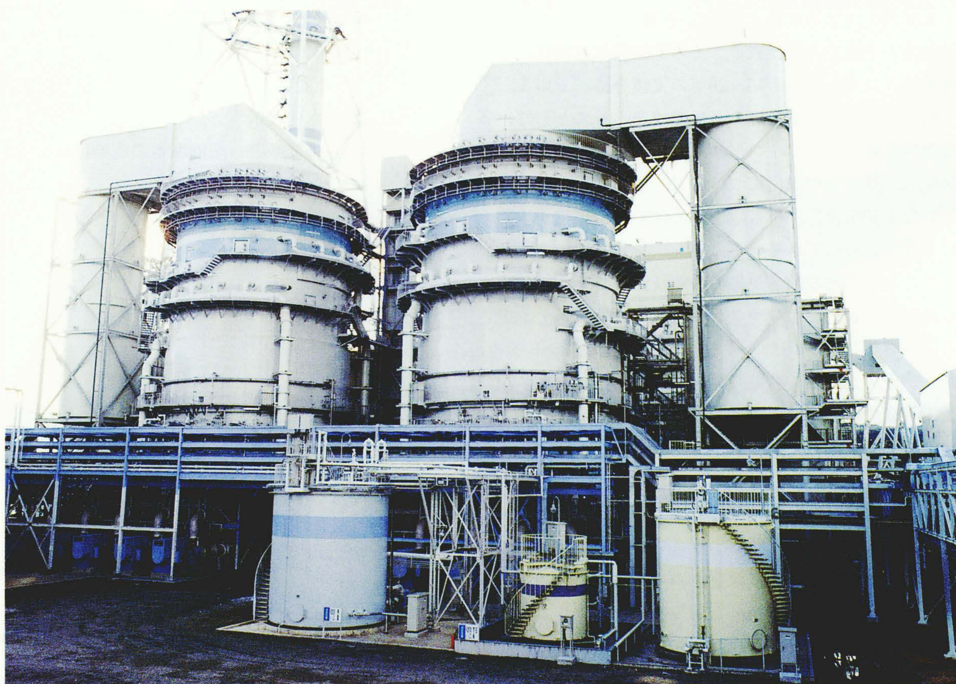
電源開発株式会社松浦火力発電所納め第1号機用排煙脱硫装置 わが国最大容量のこのプラントは、平成2年6月の営業運転開始以来順調に運転を継続している。
