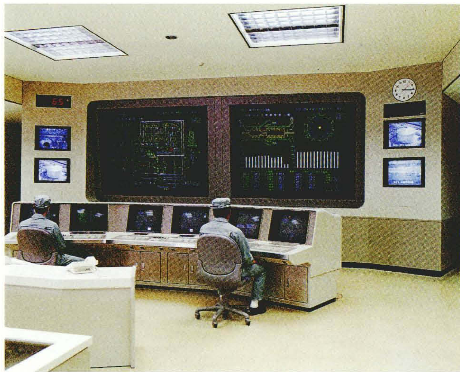
図5 大形スクリーン適用例 大形スクリーンは計算機のCRT画面、現場監視ITV(工業用テレビジョン)画面などの画面情報を拡大表示し、運転員全員へ情報提供を行う。
