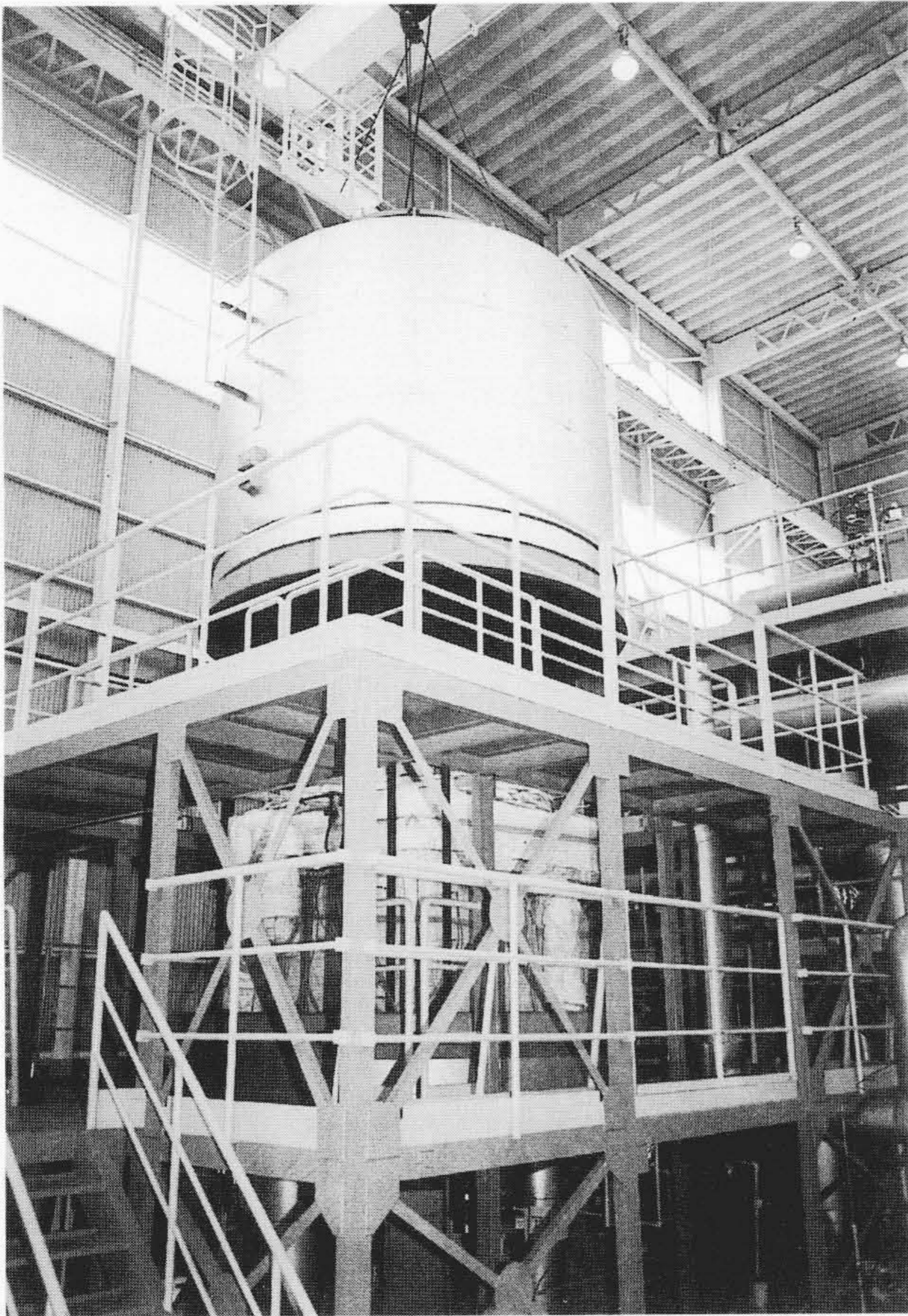
図7 加圧25 kW級スタック スタックの周囲を断熱材で覆い、圧力容器中に収納する。この写真は圧力容器を持ち上げた状態を示したものである。この圧力容器は100 kW級も収納できる大きさに製作している。
