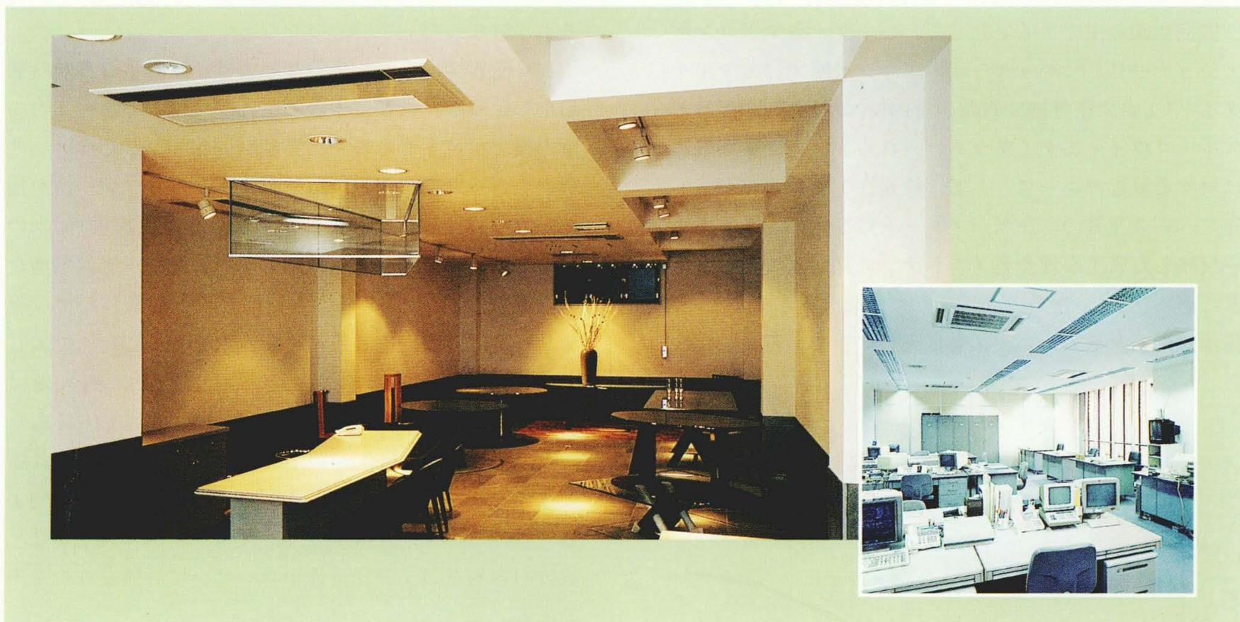
マルチエアコンディショナーの納入事例 複数の天井埋め込みカセット形エアコンディショナーを室内に設置した事例を示す。
