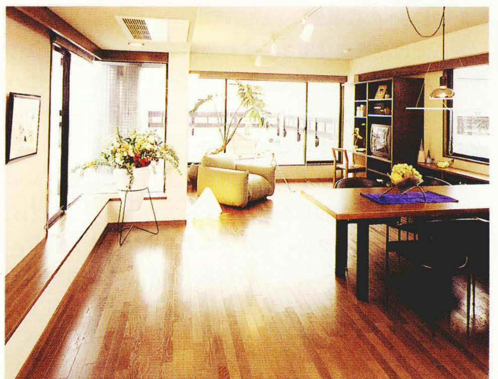
図2 リビングルームのシステムマルチエアコン マンション「コートヒルズ湘南・日向岡」の一室の下がり天井部に、吸込グリルと吐出グリルを使用して設置した、フリーダクトタイプのシステムマルチエアコンを示す。
