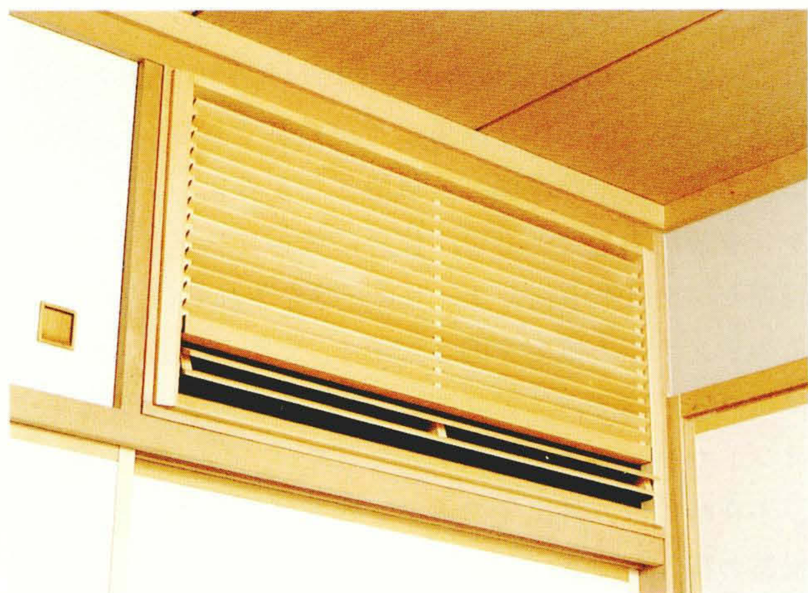
図4 壁埋込タイプの室内ユニット 社宅などの和室にフィットする壁埋込タイプのシステムマルチエアコンを示す。
