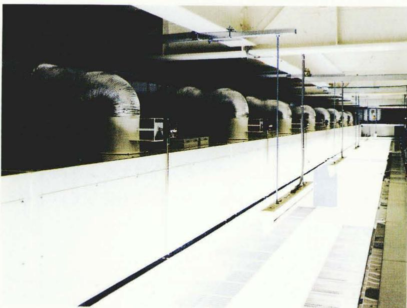
図7 天井に設置されたFFU群 クリーンルームの天井内に設置したFFUの例を示す。各ユニットに空調空気のダクトが接続されている。
