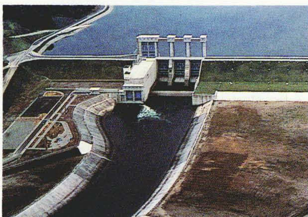
(a) 電源開発株式会社只見発電所
