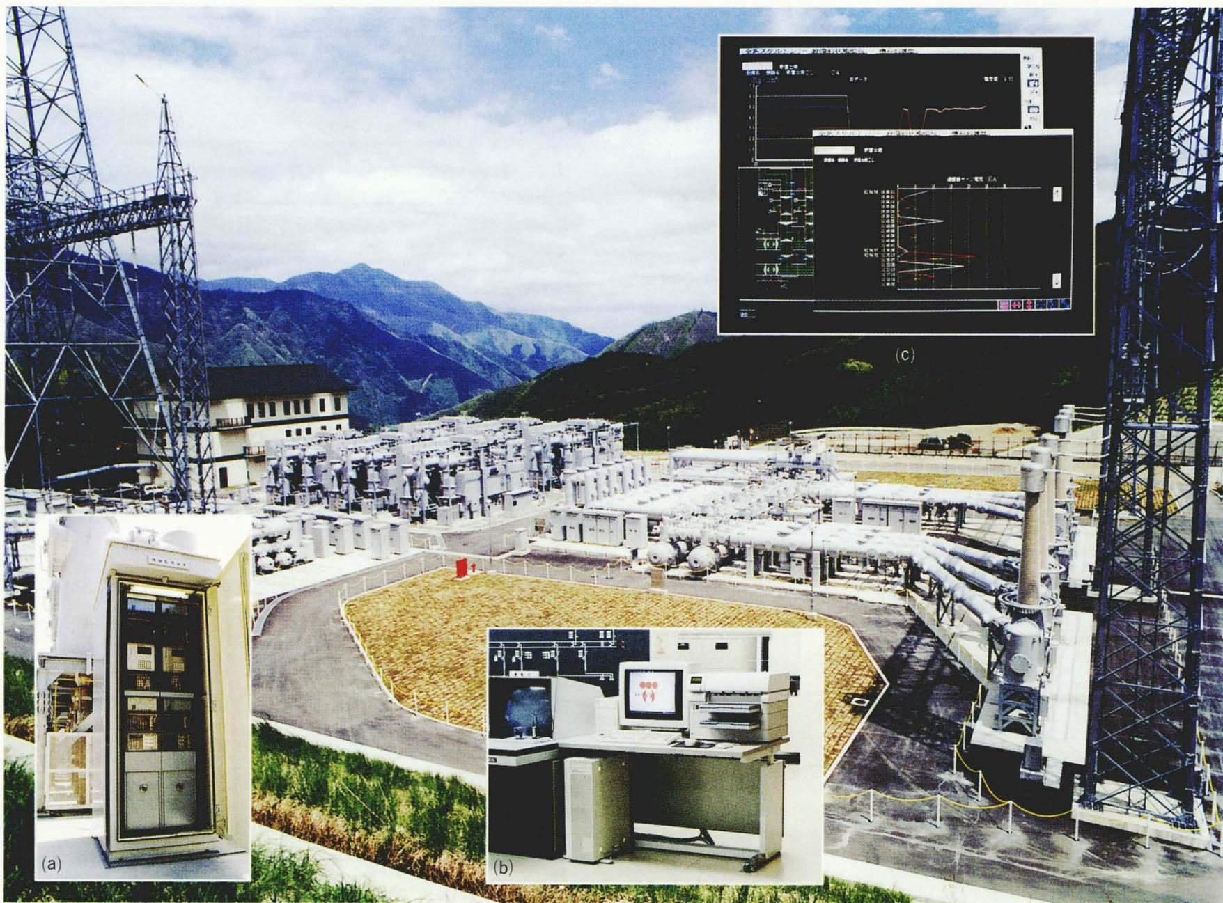
東京電力株式会社東山梨変電所納め運転・保守支援システム 超高压, 基幹系の変電所では, 機器の縮小化・ブラックボックス化に対応した新しい保守・点検技術の適用が進んでいる。また, 万一の機器の事故に際し, 系統復旧の迅速化を目指した故障点標定技術の向上も図られており, これらは運転・保守支援システムとして実用化の段階に入った[(a) 機器監視端末, (b) 運転・保守支援マンマシン, (c) CRT表示例]。
