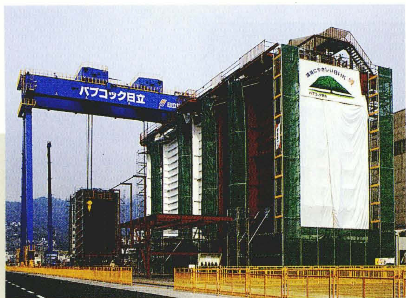
呉工場のモジュールヤード。エアリフトによりブロック化されたボイラ部品が、300 tガントリークレーンで組み立てられていく。
