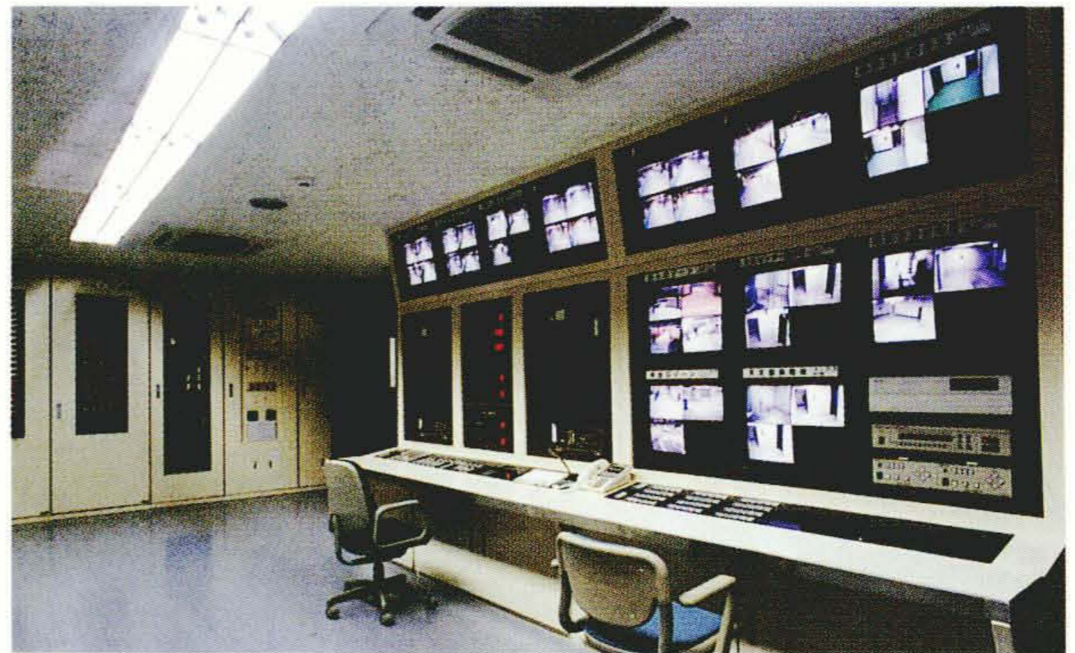
鹿児島中央地下駐車場株式会社納め中央監視室
