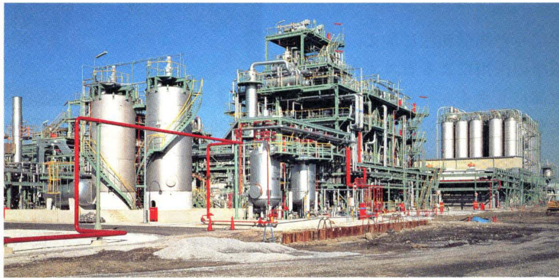
新日鐵化学株式会社納めポリスチレン製造設備
