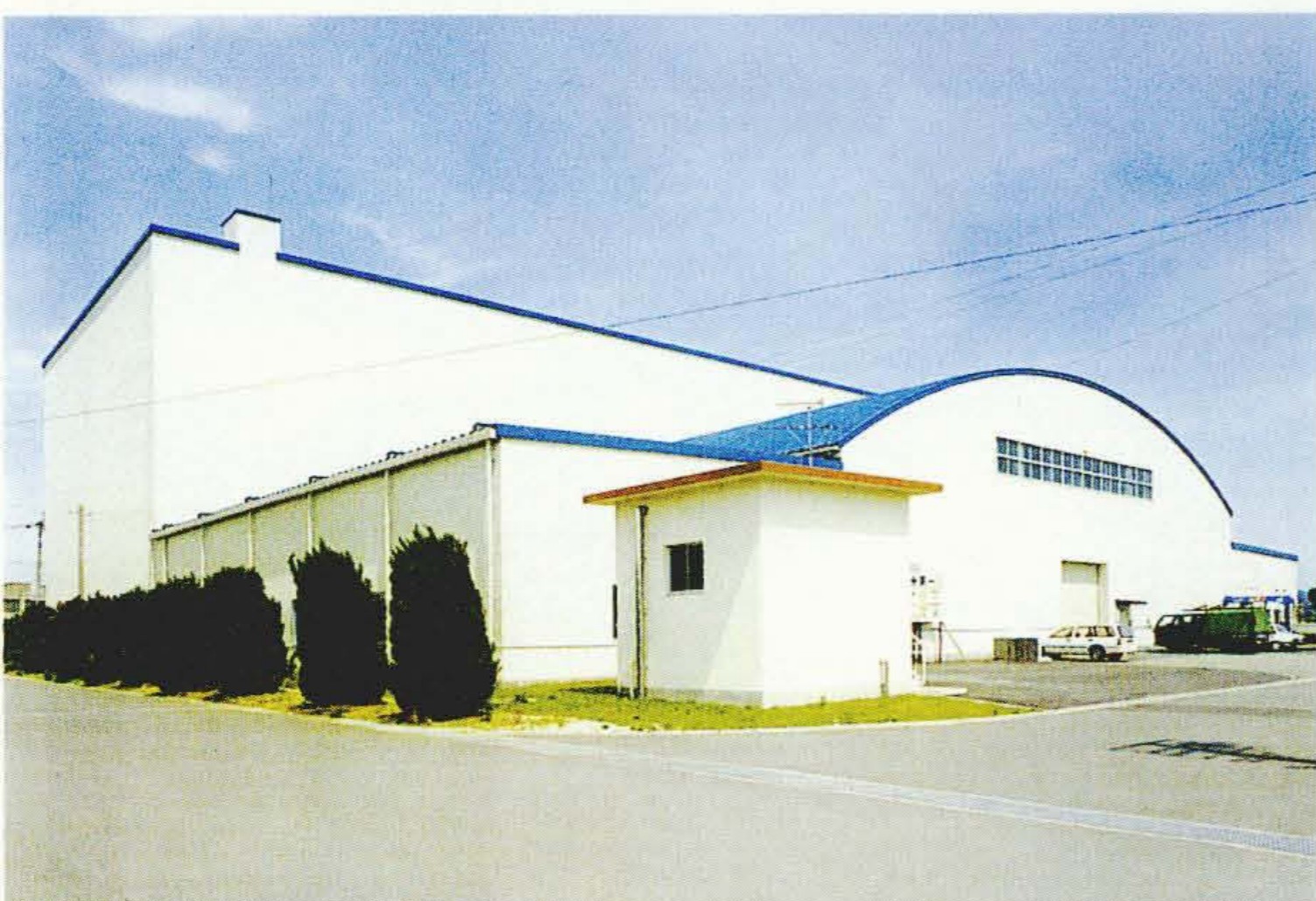
海上自衛隊佐世保補給所自動倉庫の外観
