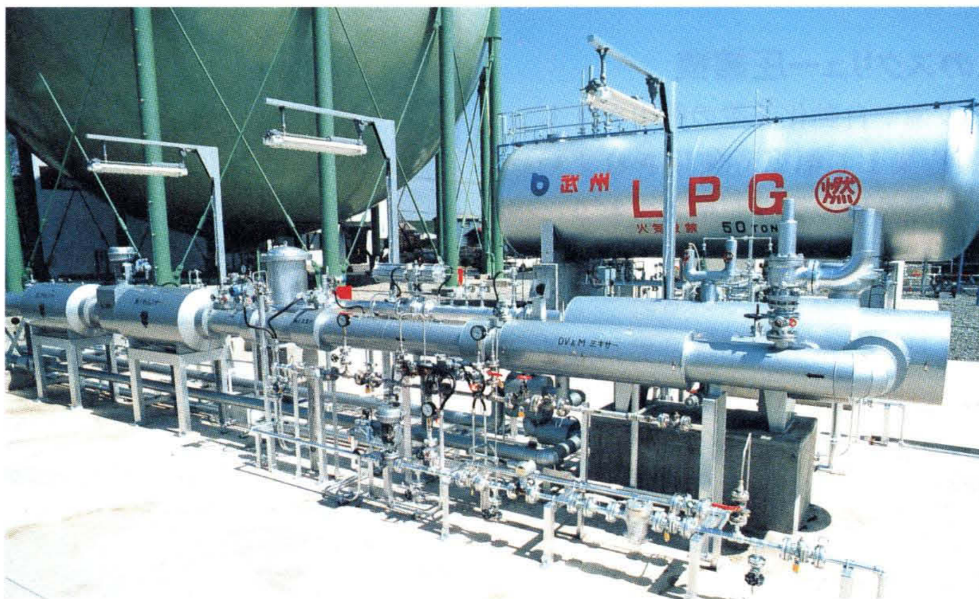
武州ガス株式会社吉見製造所納めDV&M熱量調整設備
