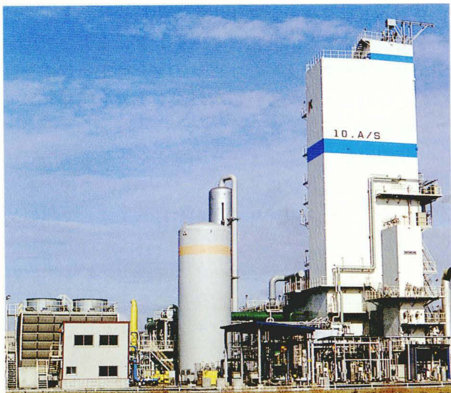
川崎製鉄株式会社水島製鉄所納め希ガス回収設備
