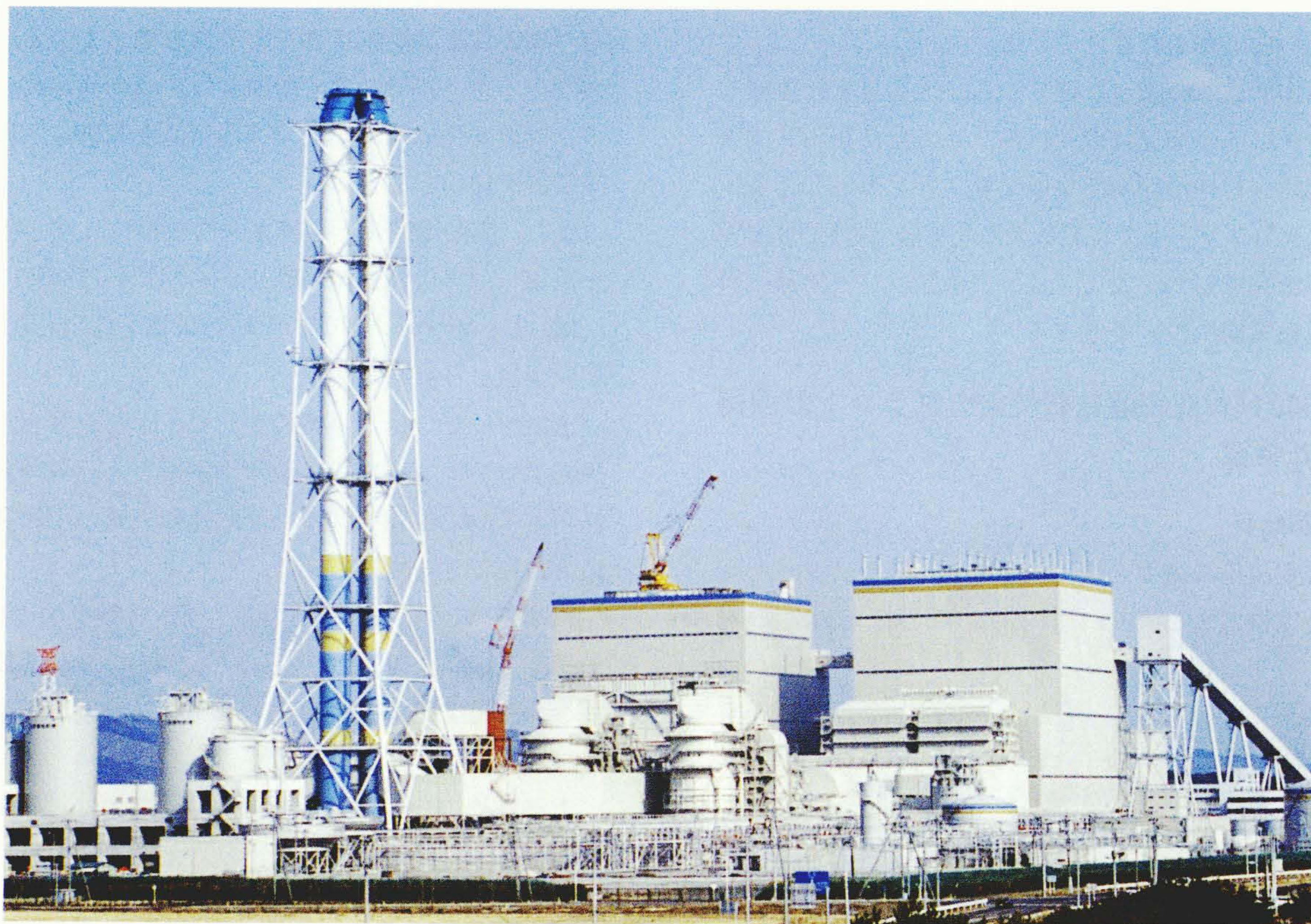
相馬共同火力発電株式会社納め新地発電所1号プラント 1,000 MW石炭燃焼プラント2ユニットから成る発電所を示す。右側が1994年7月に営業運転を開始した1号プラントである。
