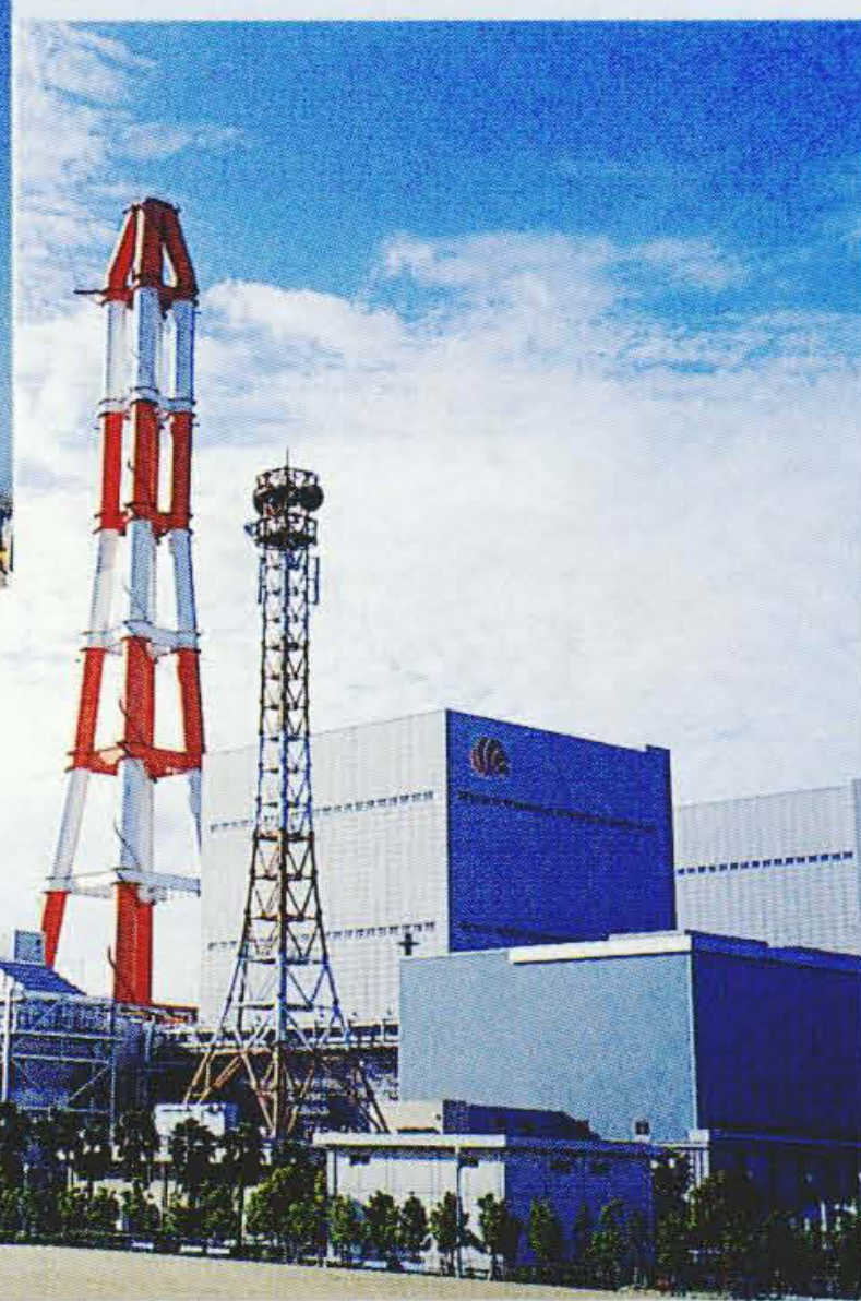
中部電力株式会社知多第二火力発電所1号機
