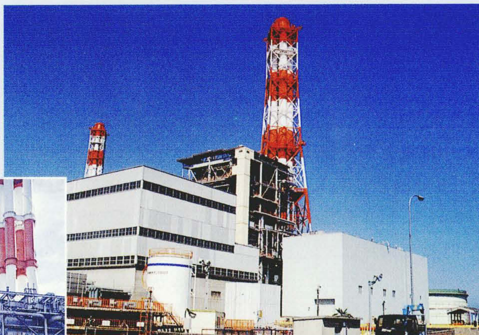
東京電力株式会社五井火力発電所6号機
