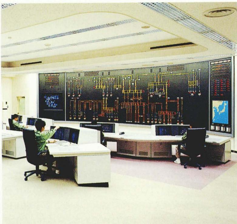
水力発電所・変電所用大規模集中監視制御システム
