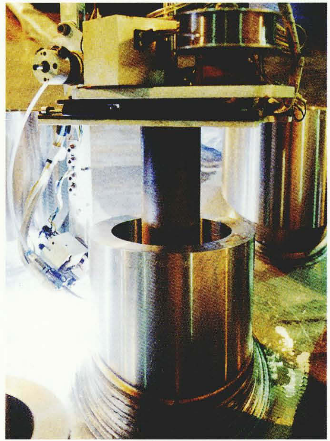
図3 CRDスタブの三次元自動溶接作業状況 世界に先駆けてCRDスタブの三次元自動溶接を適用し、信頼性、効率の向上を図った。
