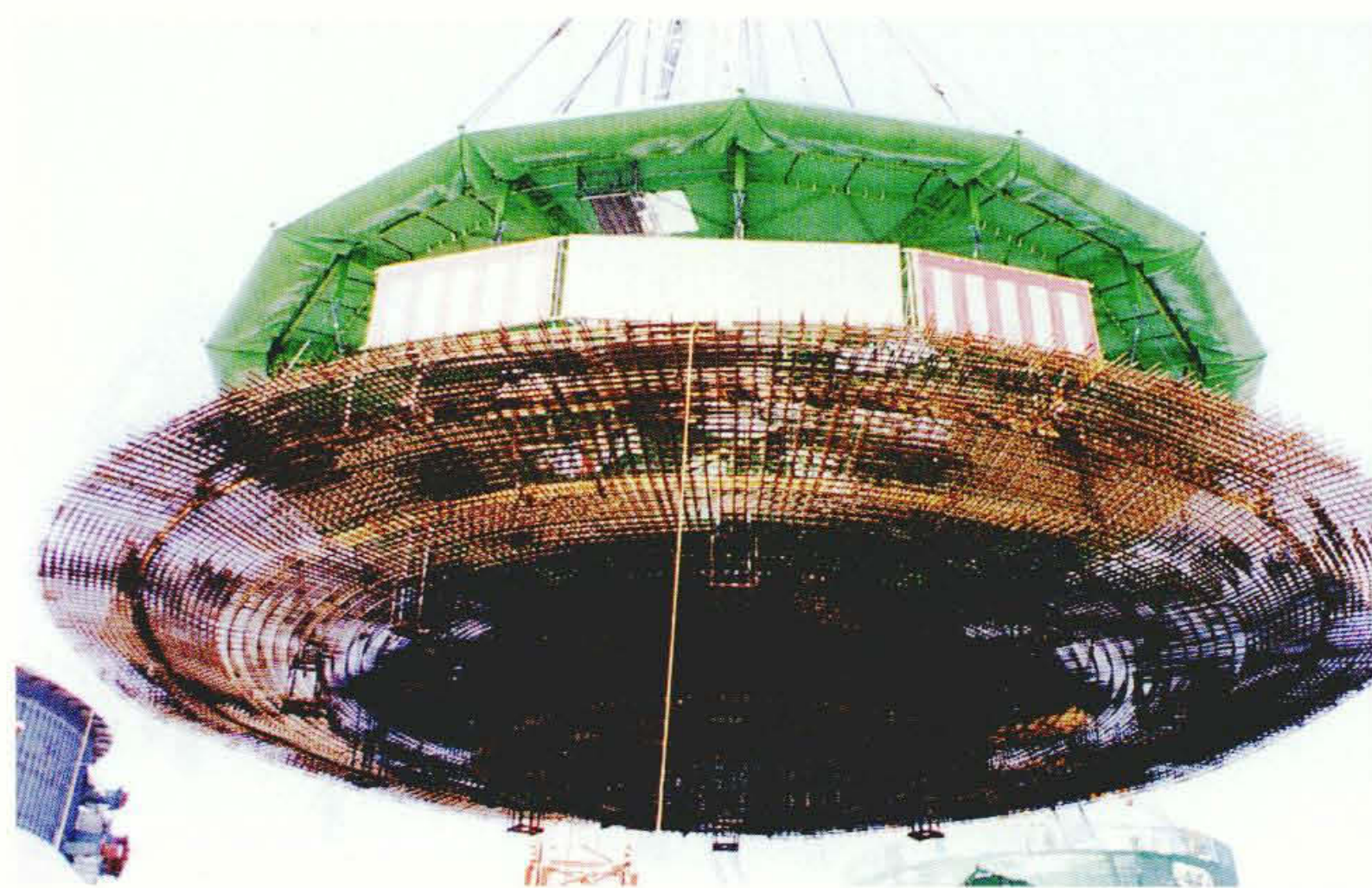
図5 基礎ボルトとマットの鉄筋モジュール
