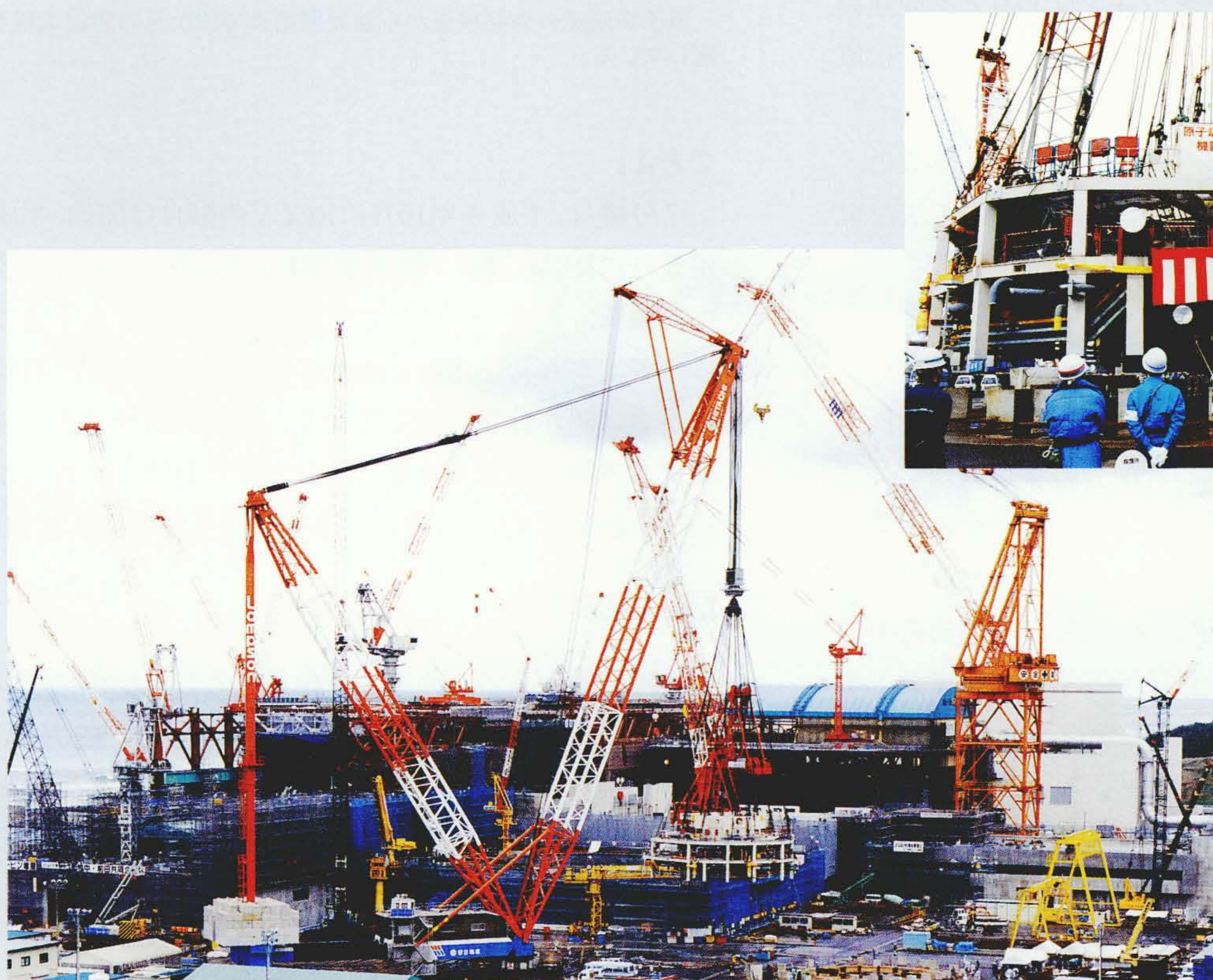
RCCV(鉄筋コンクリート製 原子炉格納容器)内超大型モ ジュールの搬入状況
