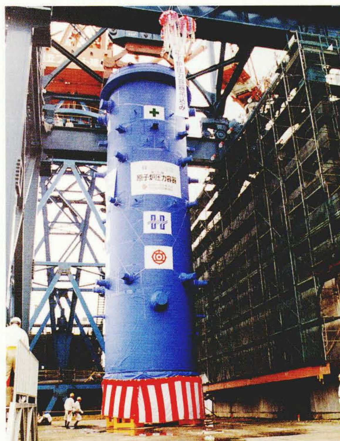
図3 原子炉圧力容器のつり込み
