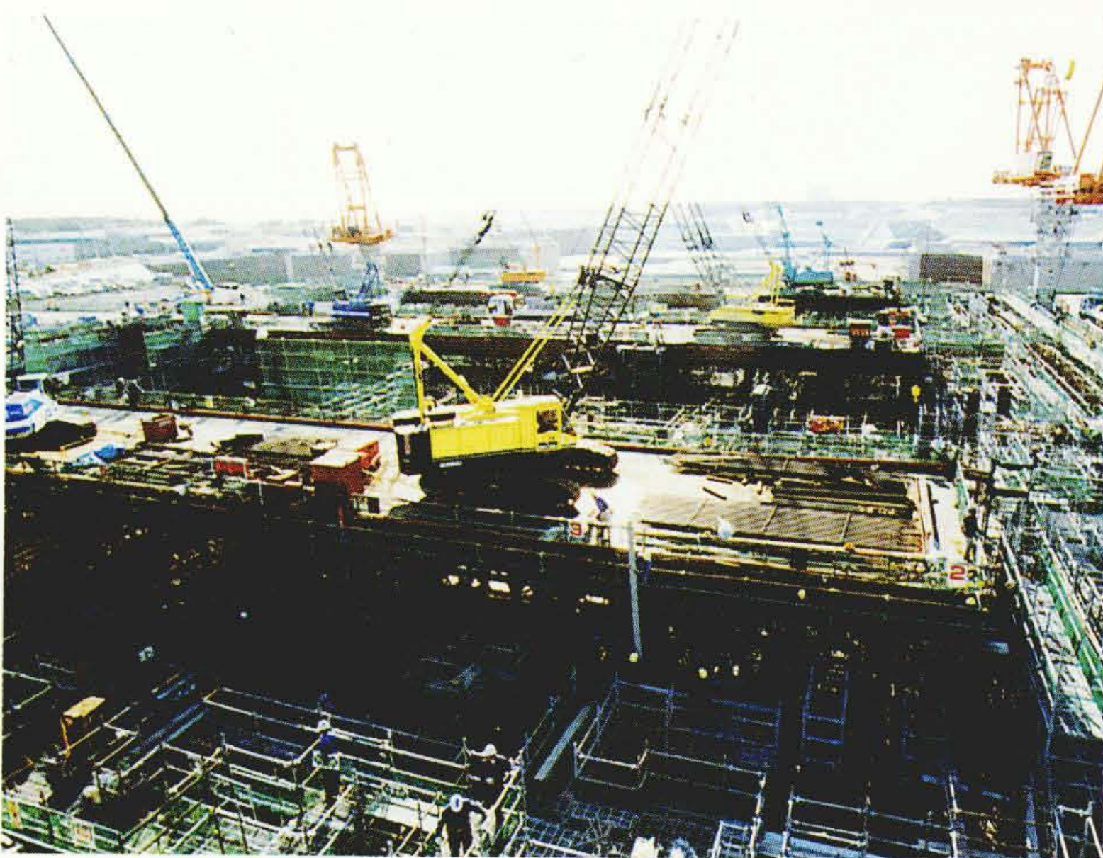
図3 日本原燃株式会社六ヶ所再処理工場の建設状況 1993年4月に着工した使用済燃料受け入れ施設・貯蔵施設の建設が順調に進んでいる。
