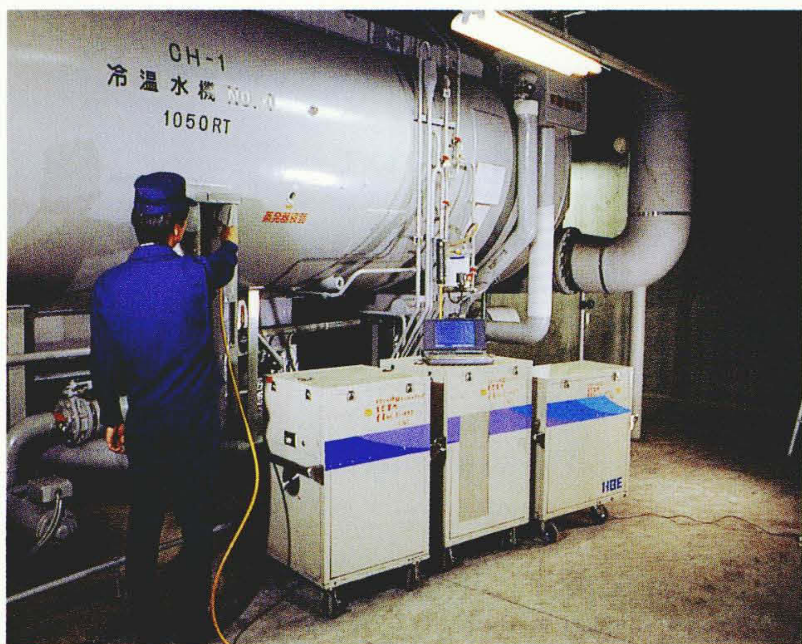
図3 運用中の真空気密診断装置 真空気密診断装置により、運転中に微小漏れ部位が特定できる。
