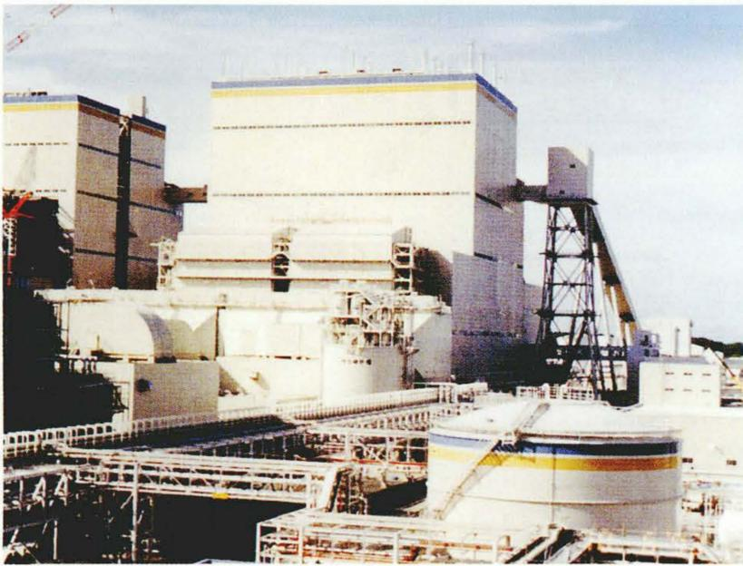
図4 相馬共同火力発電株式会社新地発電所1号機用脱硝装置
