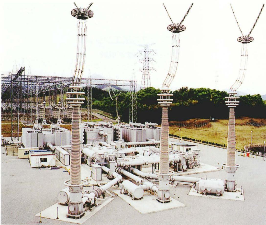
東京電力株式会社新榛名変電所構内に設置したUHV機器試験場。ここで100万V送電の導入を目指して長期実証試験を実施している。
