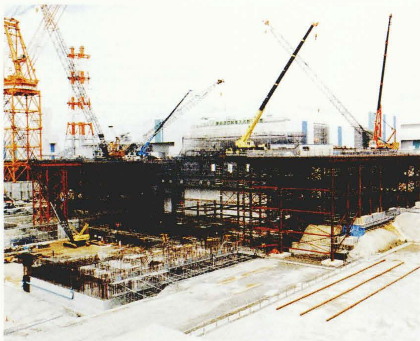
日本原燃株式会社の使用済燃料の受け入れ施設および貯蔵施設の建設状況(1996年10月)
