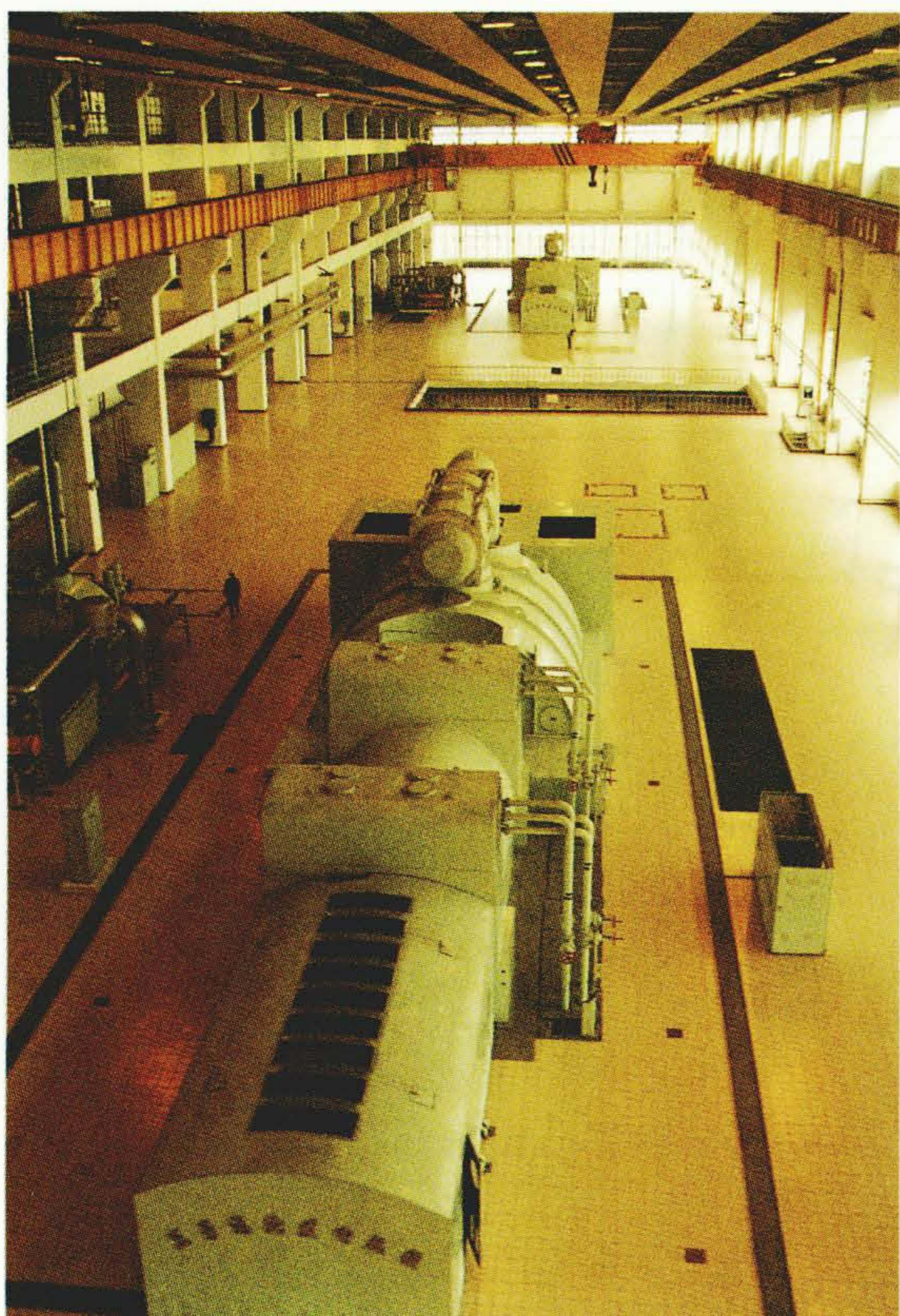
中国偃师発電所 3号,4号蒸気タービン
