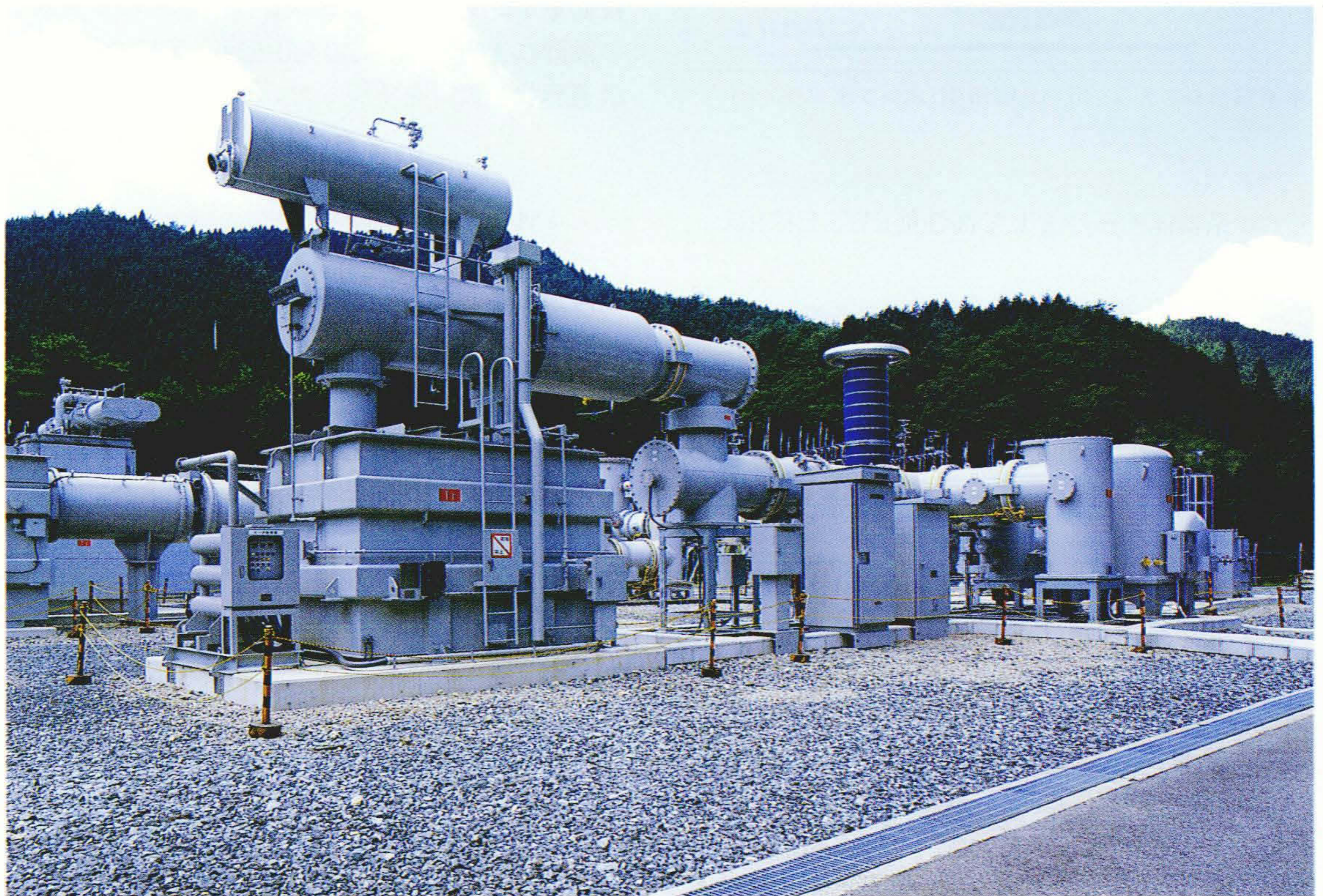
長期性能試験中の直流GIS, 変換用変圧器・直流リアクトルの実規模モデル
