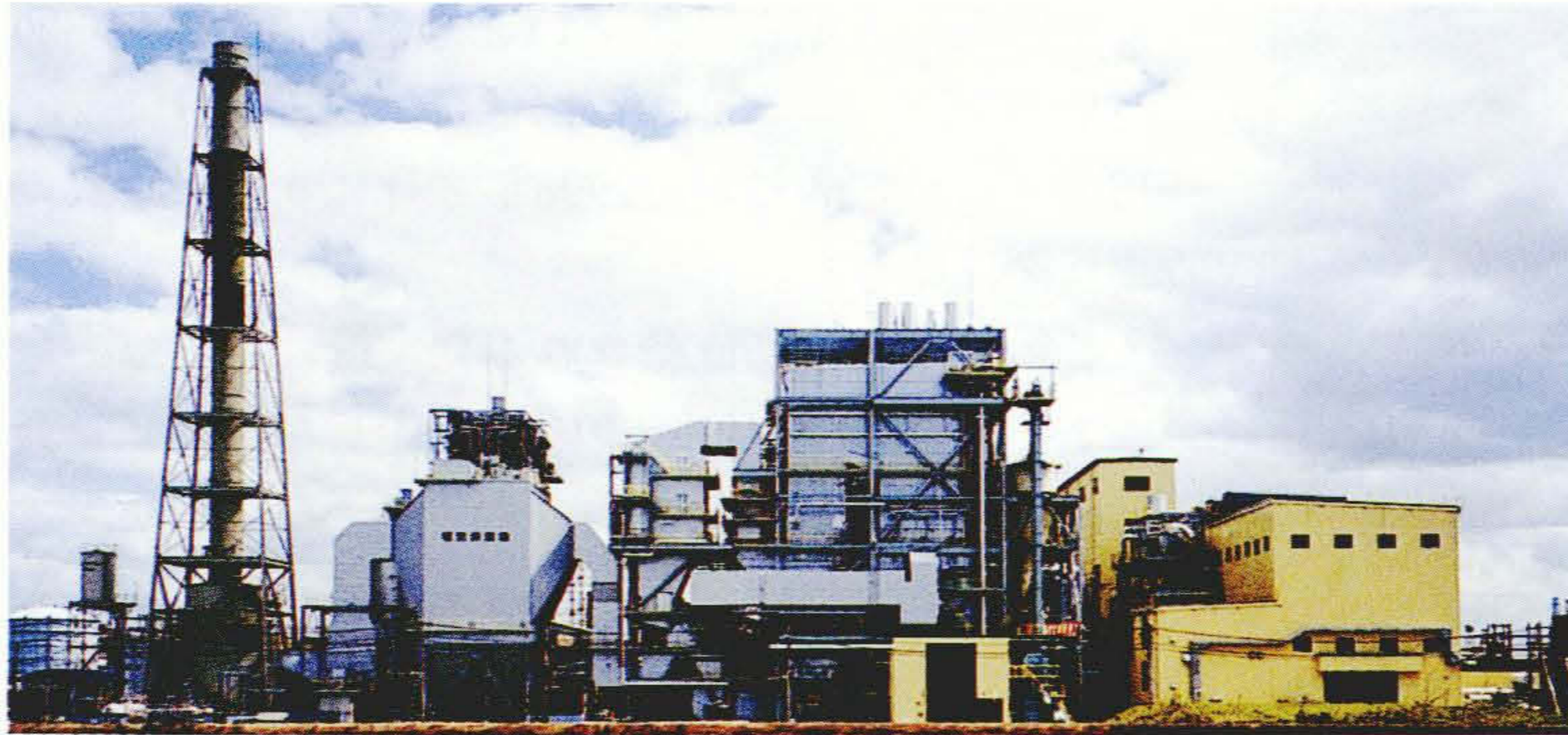
新日本製鐵株式会社広畑製鐵所納め第6号発電設備
