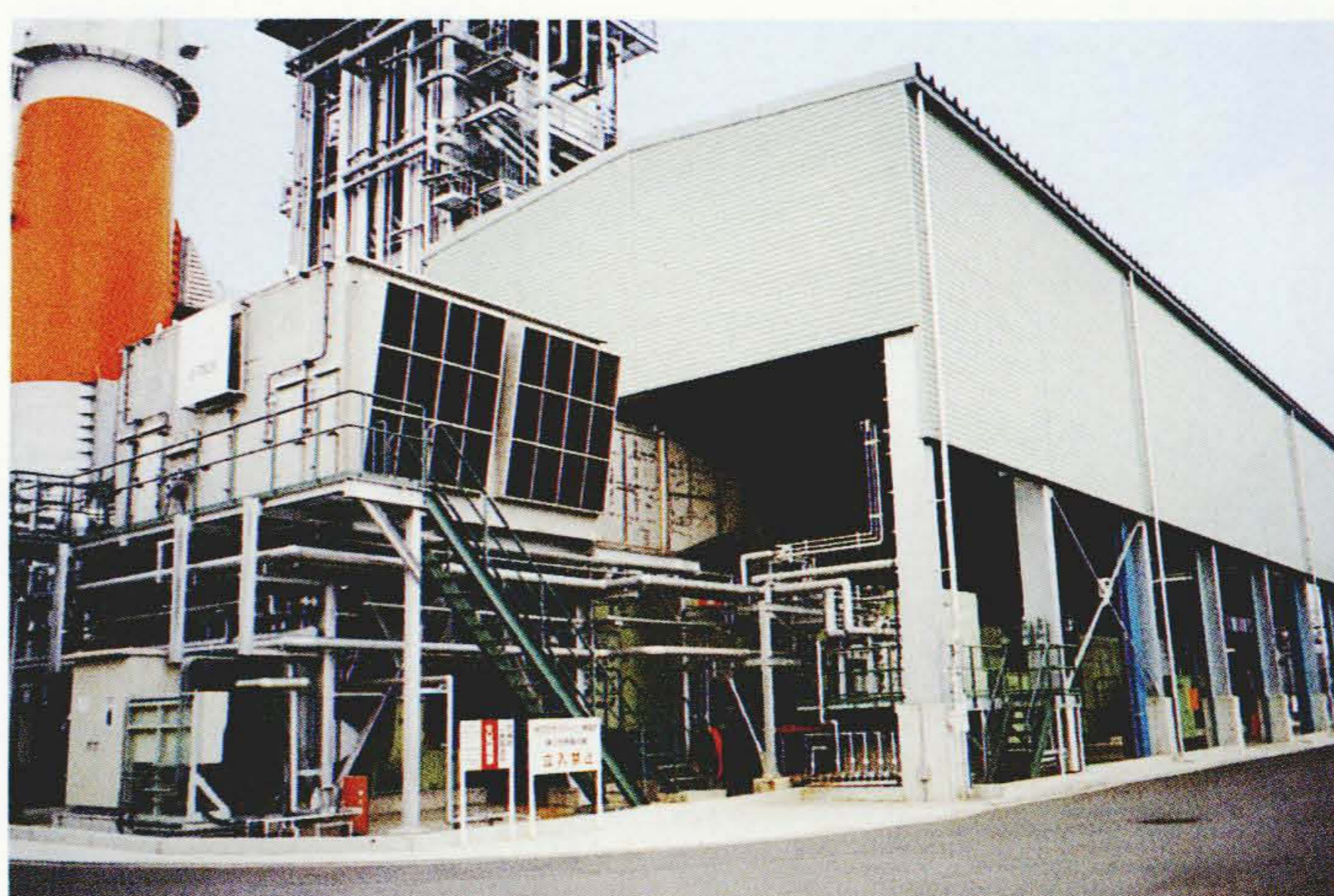
昭和四日市石油株式会社四日市製油所納め 25 MWガスタービンコージェネレーション設備
