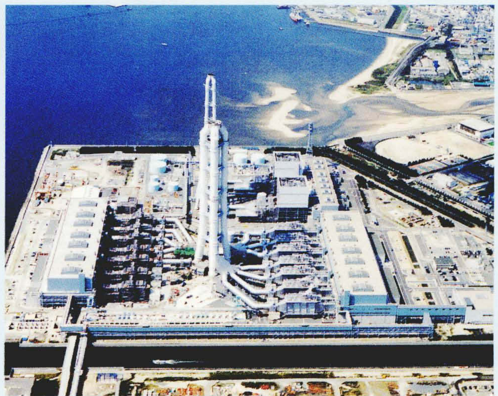
中部電力株式会社川越火力発電所3号系列
