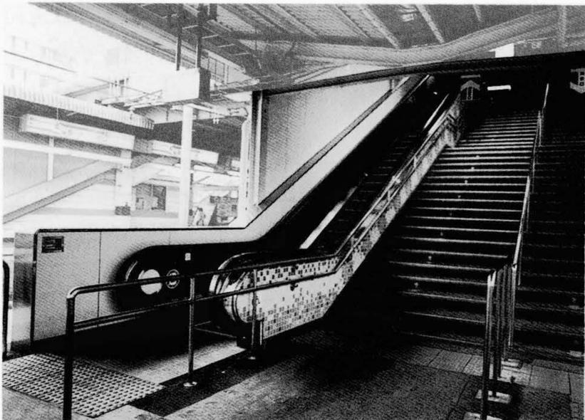
図3 常磐線の松戸駅に設置した階段手すり一体型エスカレーター
