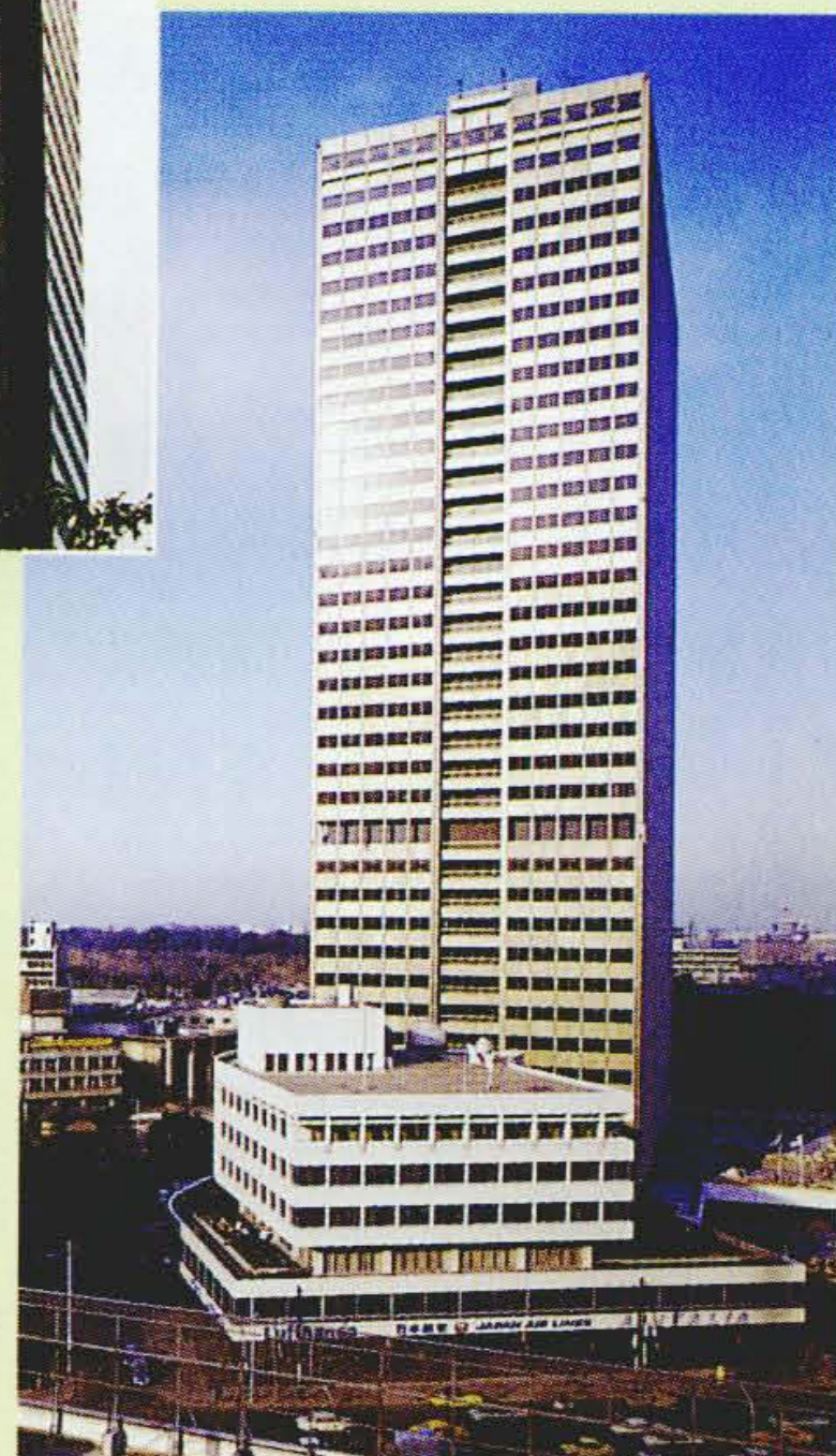
竣(しゅん)工当時の霞が関ビル
