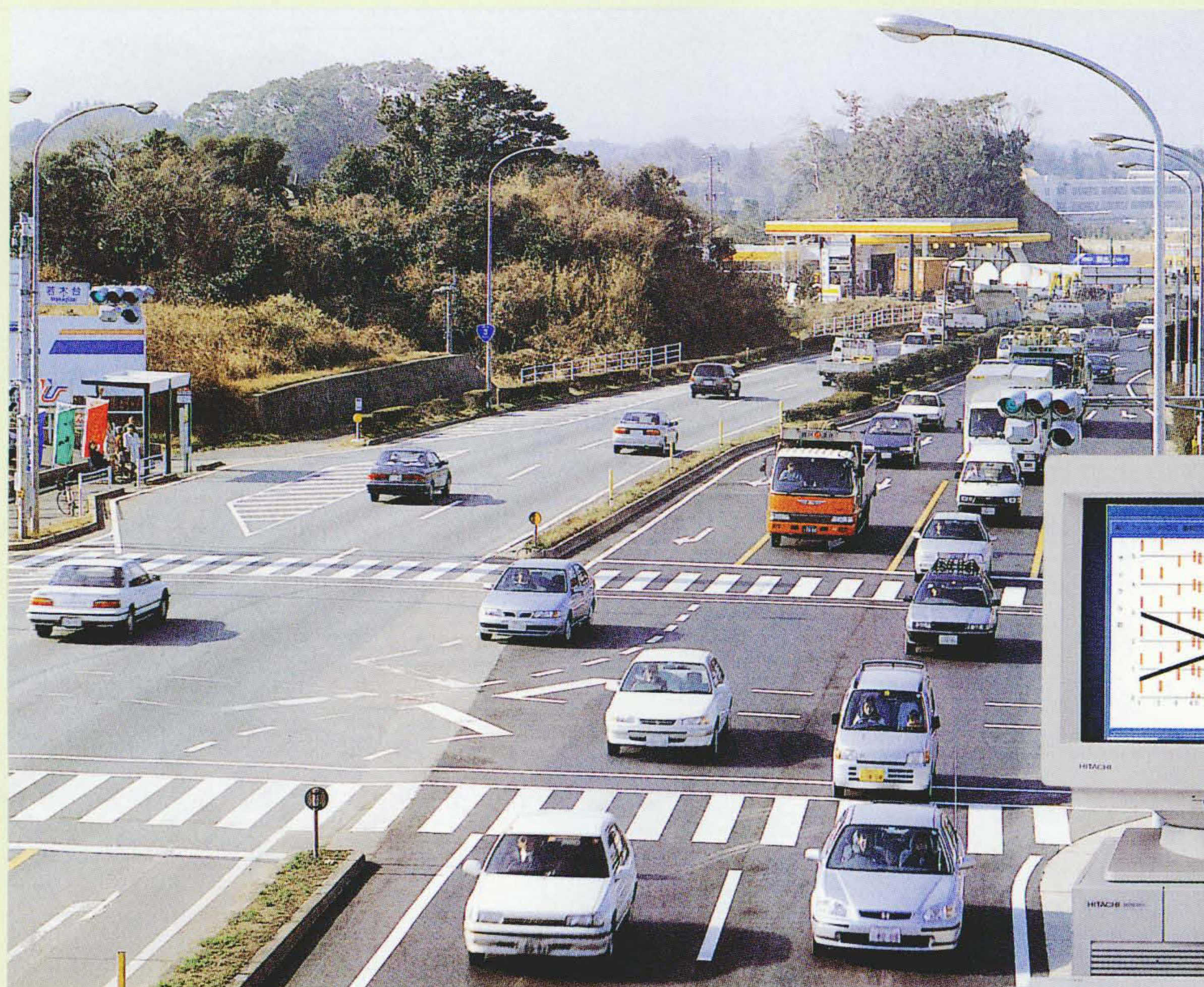
福岡県宗像地区の国道3号線
