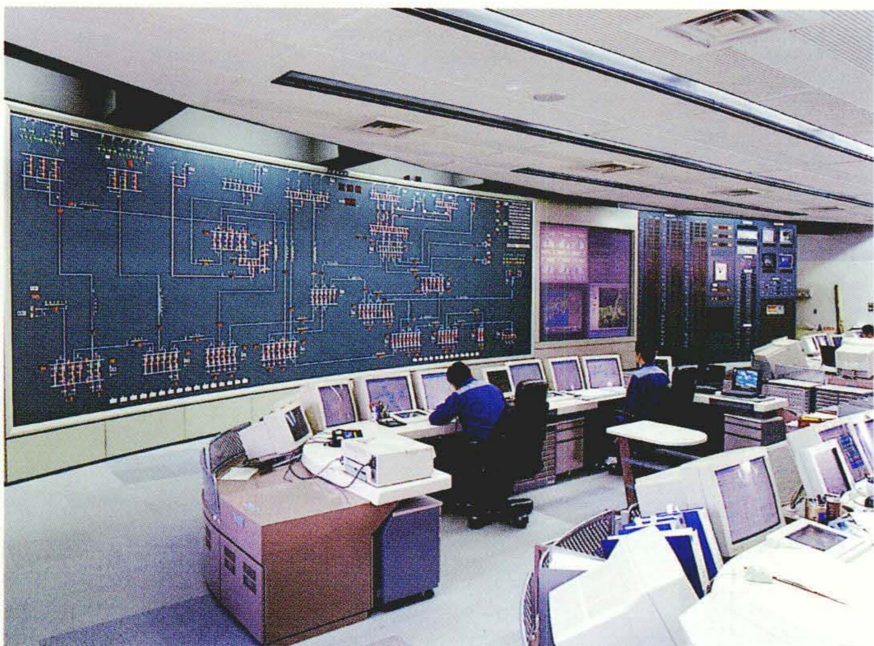
大型ディスプレイなどを利用して、運用者に優しいヒューマンインタフェースを実現した中央給電指令所の監視指令室。画面の情報は日立製作所の計算機から送られている。
