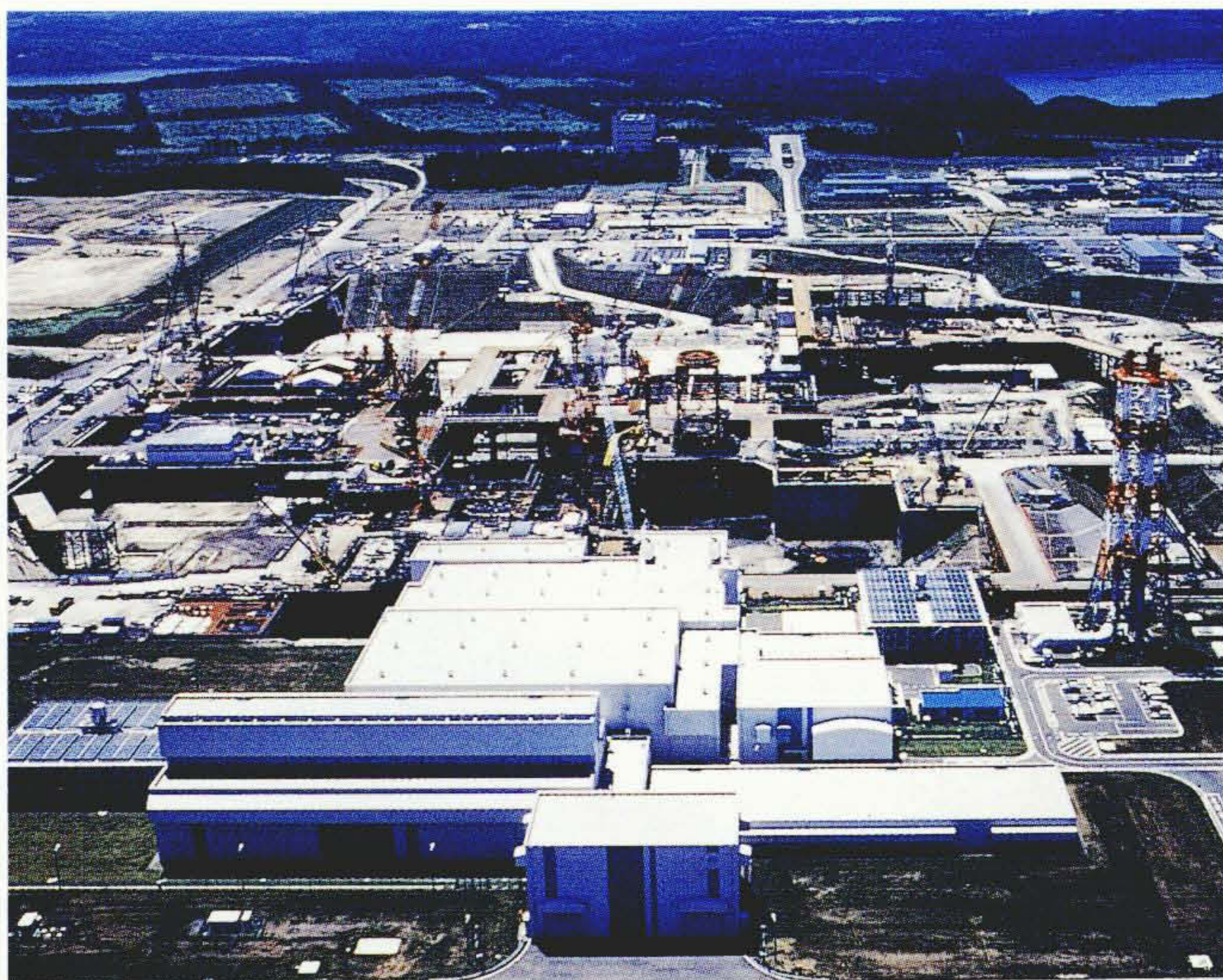
軽水炉燃料再処理施設の工事状況(1998年7月撮影)
