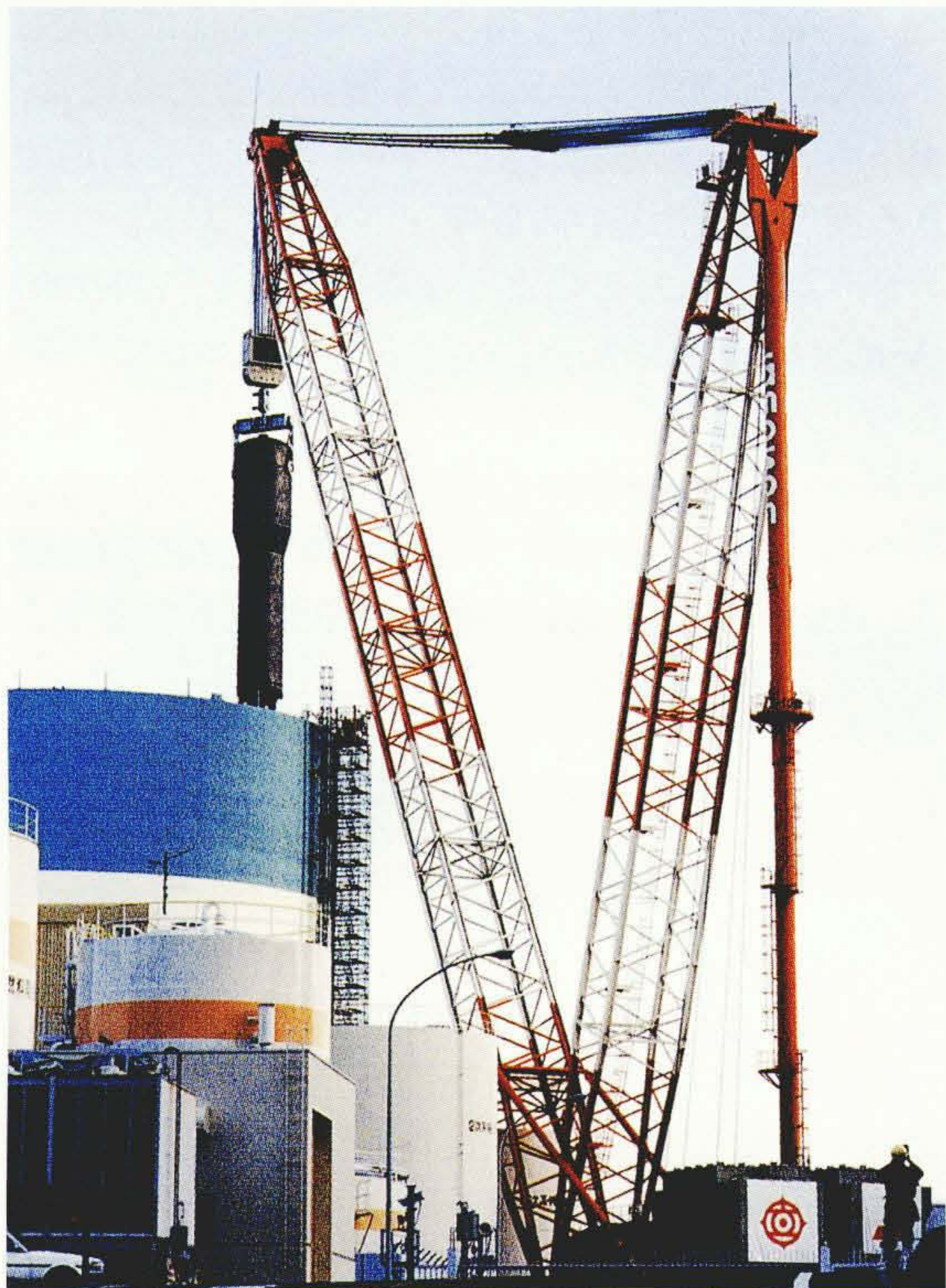
大型移動式クレーンによる蒸気発生器の搬出状況
