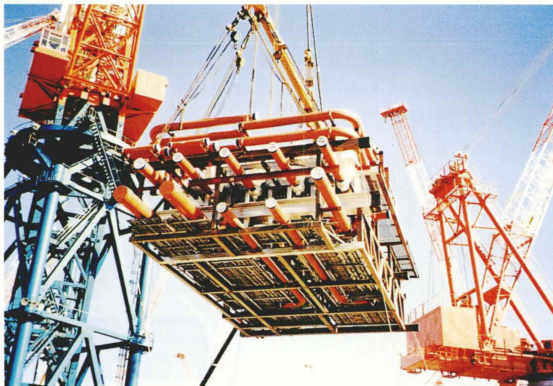
高圧タービン架台開口部モジュールの現地つり込み
