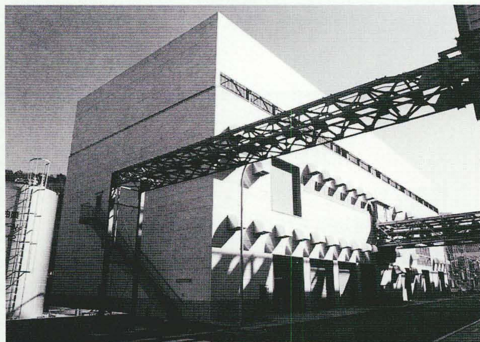
(a) アイシン・エイ・ダブリュ株式会社岡崎工場エネルギー棟の全景
