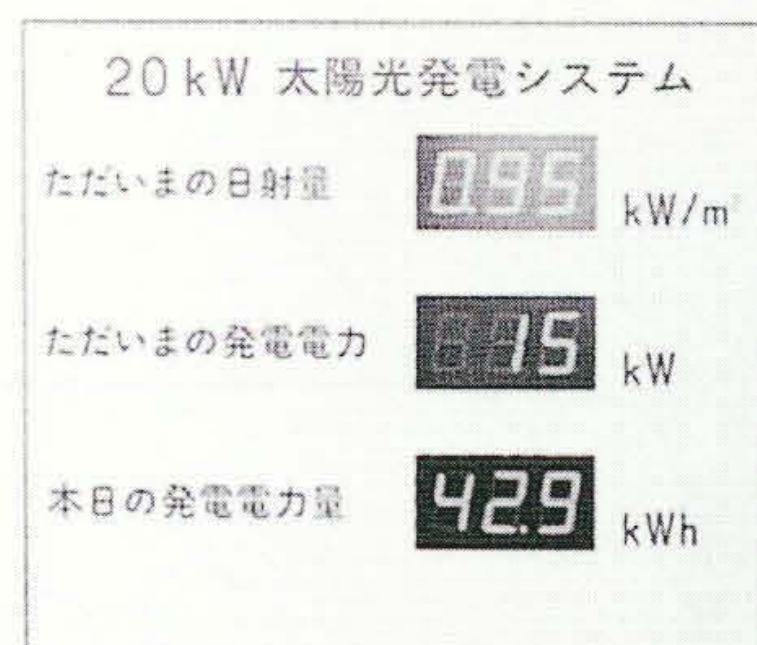
(b) 発電状況表示パネル
