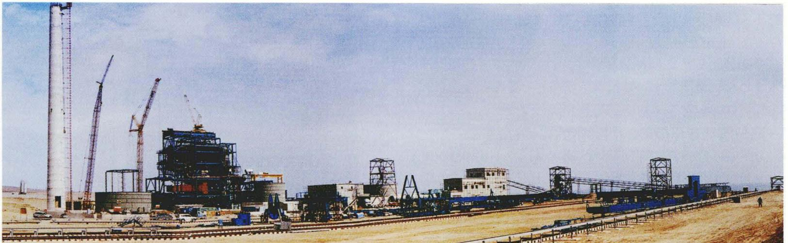
南米ペルーのイロで建設中の125 MW石炭火力発電所。EPCの第1号で、海洋土木工事から石炭の荷役施設、貯炭場、発電プラントまでのすべてを建設している。煙突の見えるところが発電プラントになる。
