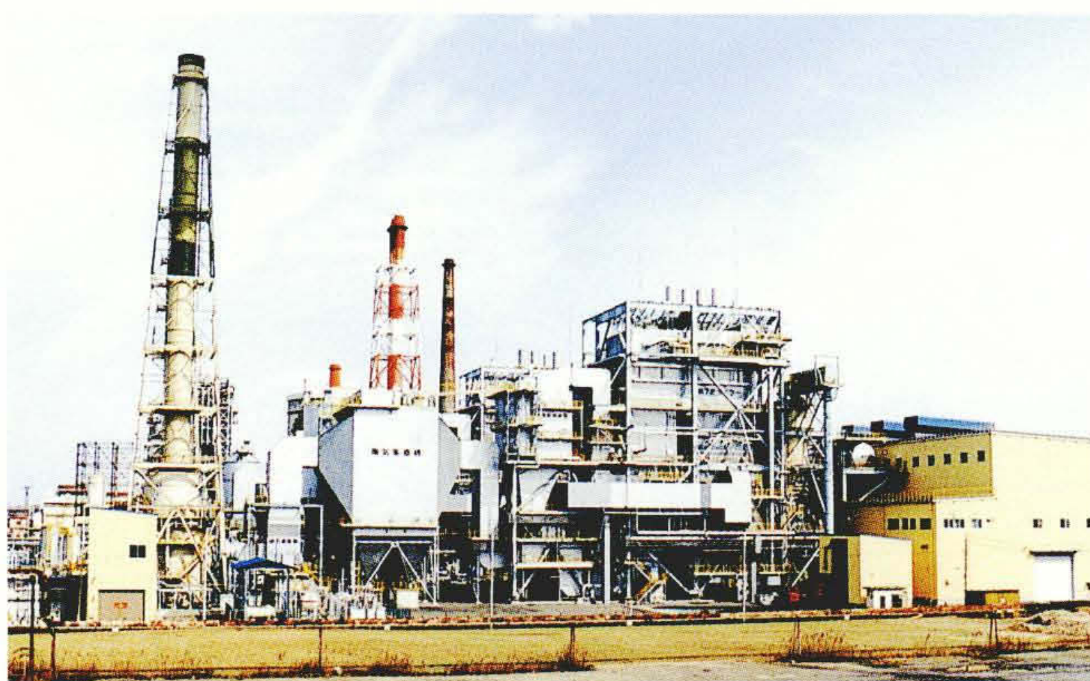
新日本製鐵株式会社広畑製鐵所広畑発電所納め 第7号発電設備
