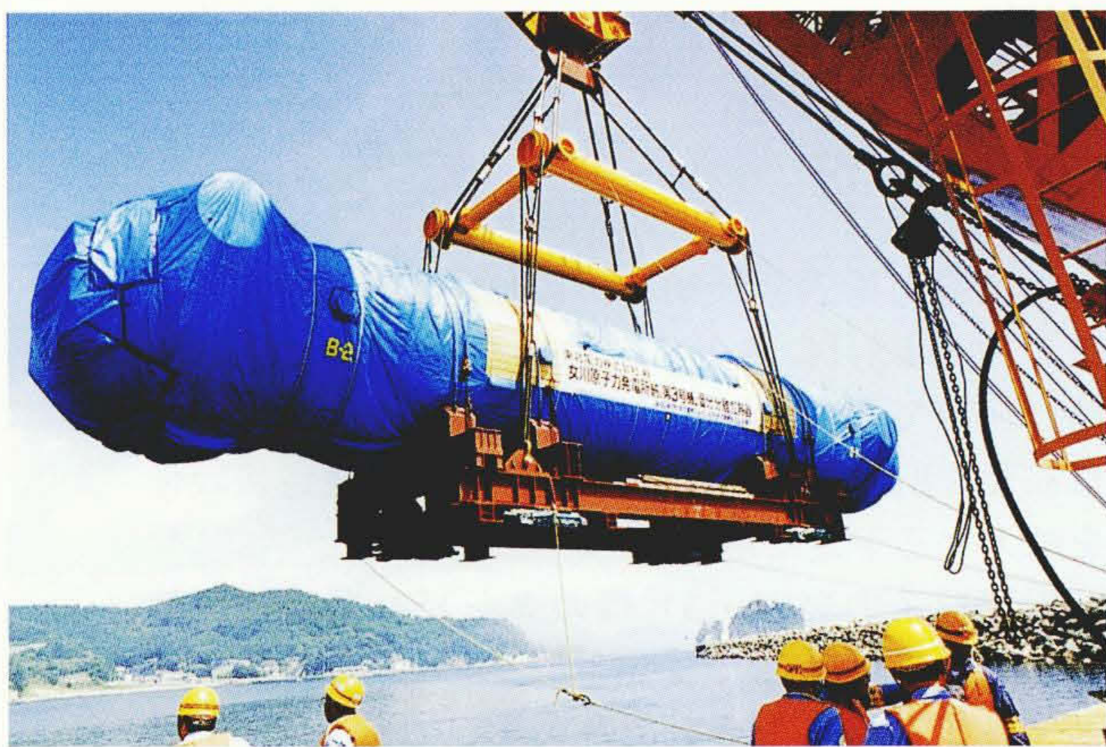
湿分分離加熱器の現地搬入作業
