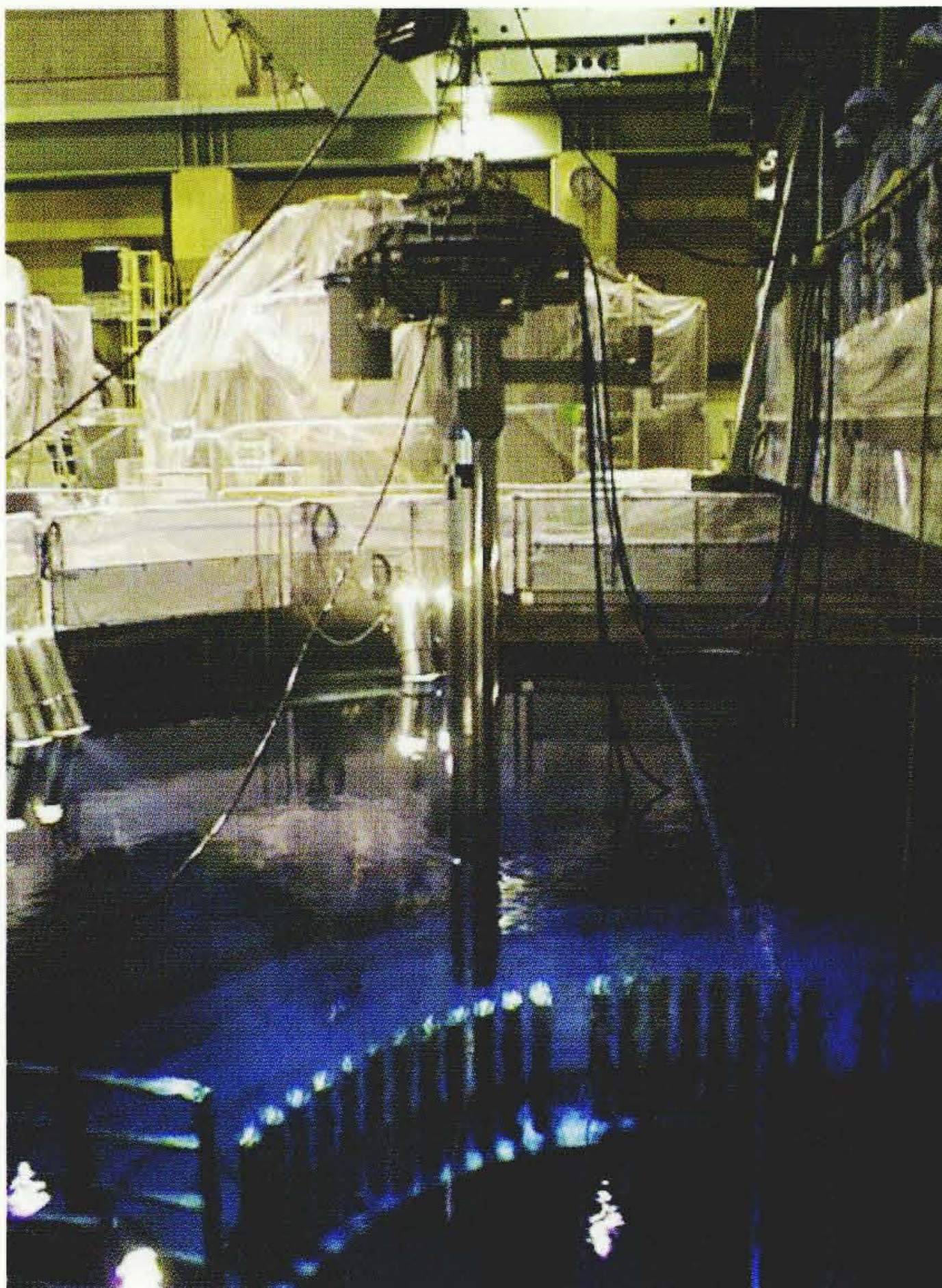
WJP主装置の原子炉内へのつり込み作業
