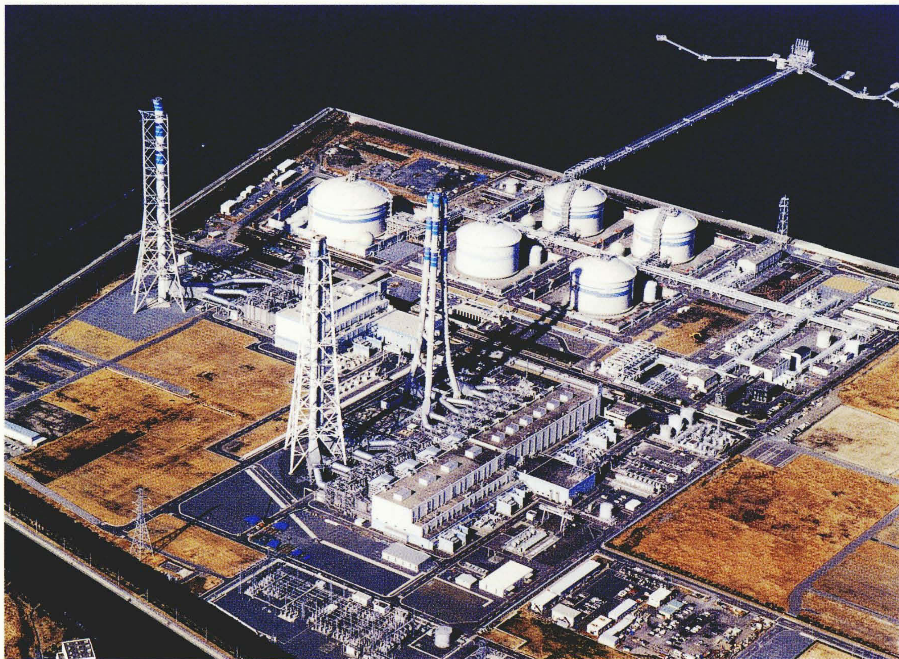
九州電力株式会社新大分発電所3-1号系列735 MWコンバインドサイクル発電設備の外観
