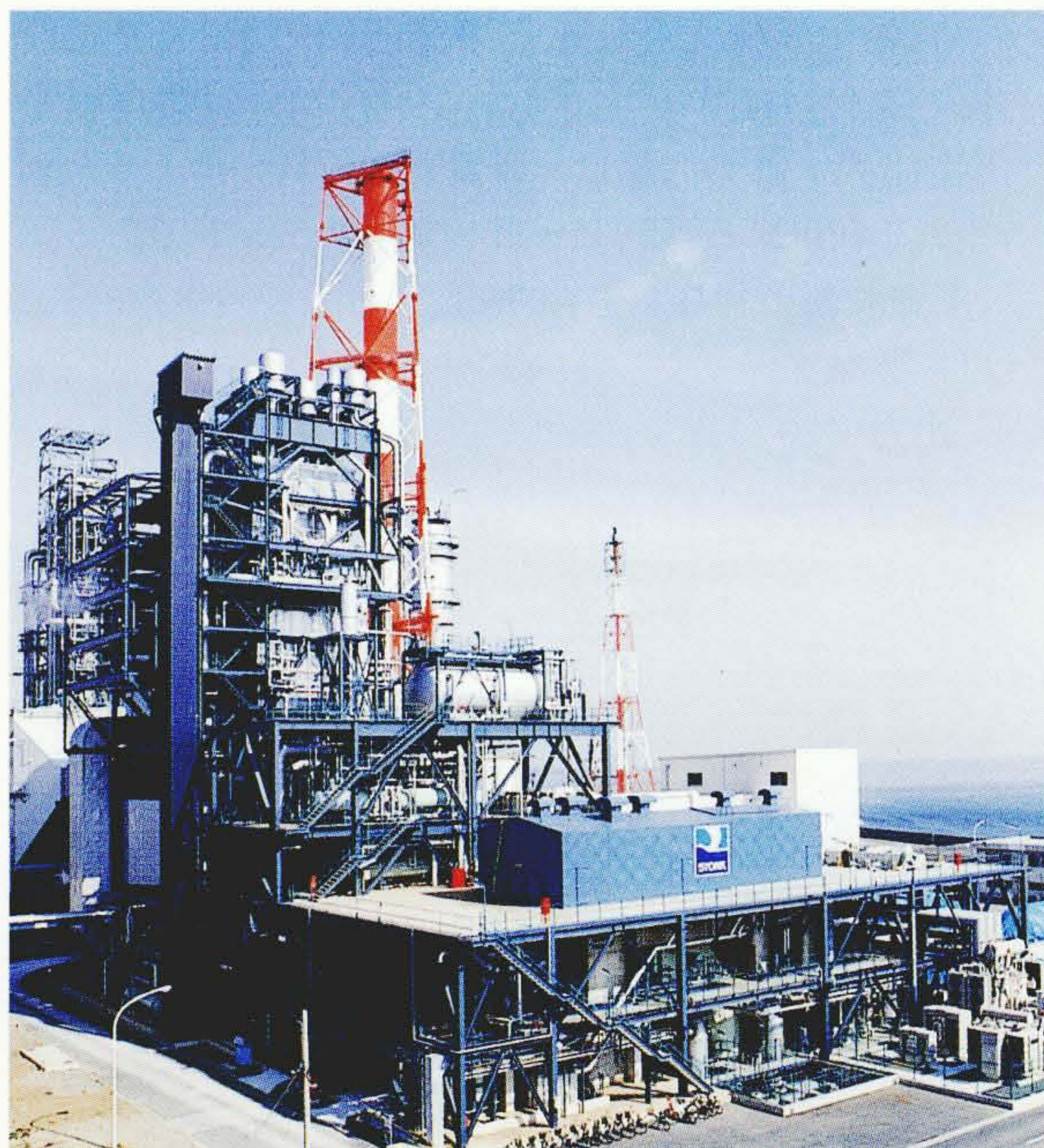
九州石油株式会社大分製油所納め大分第2発電所
