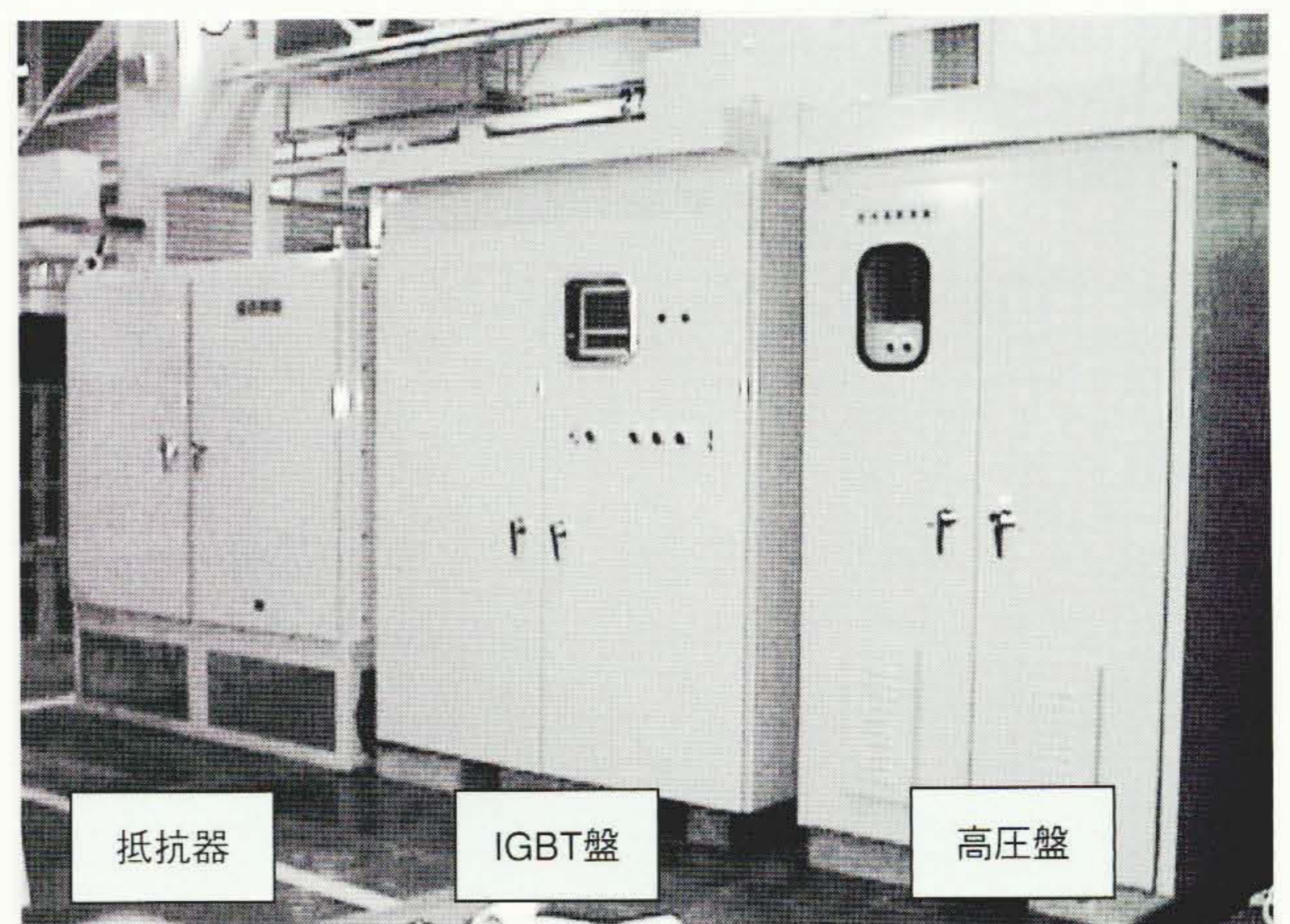
図3 回生電力吸収装置の外観 250 kW 800% 30 sの仕様としている。
