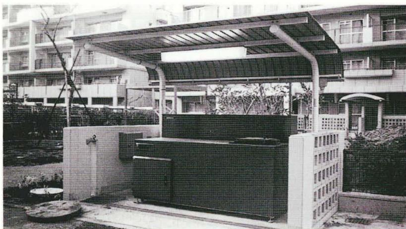
図1 集合住宅用に設置された生ごみ処理機の外観
