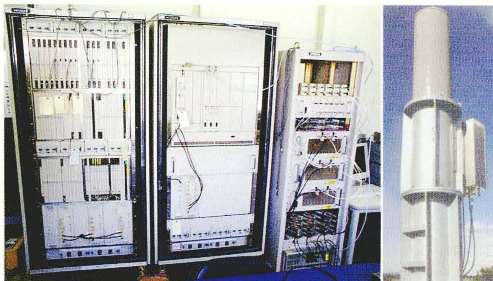
SMA機能を搭載したCDMA基地局システム(左)とアレーアンテナ(右)
