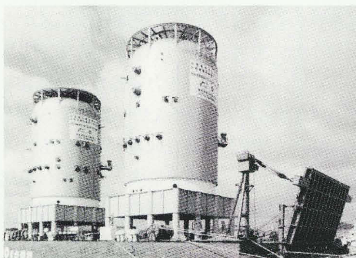
(b) 同発電所の双炉ボイラ(通称“W.B.”)の海上水切り状況
