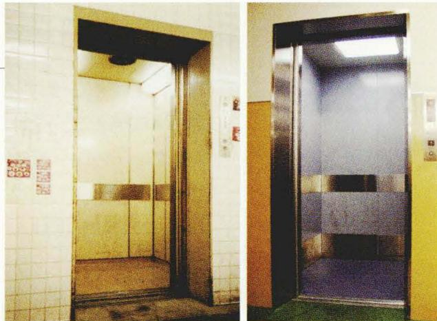
**省**スペースや省エネルギーなどの特徴を持つ機械室レスエレベーター「アーバンエース」は、低・中速(45~105 m/min)領域での日立製作所の主流機種になっている。この機械室レスエレベーターの技術を応用し、既設油圧式エレベーターを機械室レスエレベーターにリニューアルする方式を確立した。
