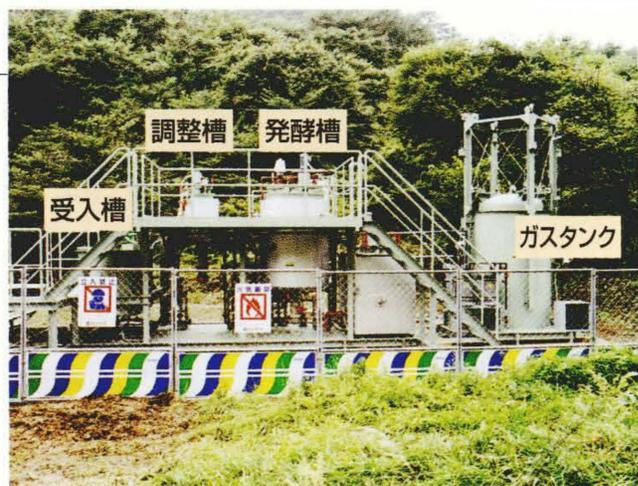
茨城県里美村に設置した生ごみ・畜糞(ふん)メタン発酵の実験装置が2001年9月中旬から稼動状態に入った。この装置では、生ごみや畜糞からエネルギーとしてのメタンガスと、コンポストや液肥などの有機農業資材が生産できる。
